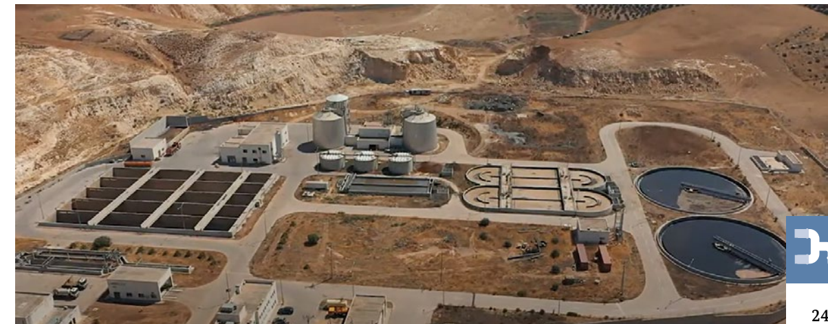
7 محطة معالجة مياه الصرف الصحي في وادي شلالة بمحافظة إربد (أعلى وأسفل)
