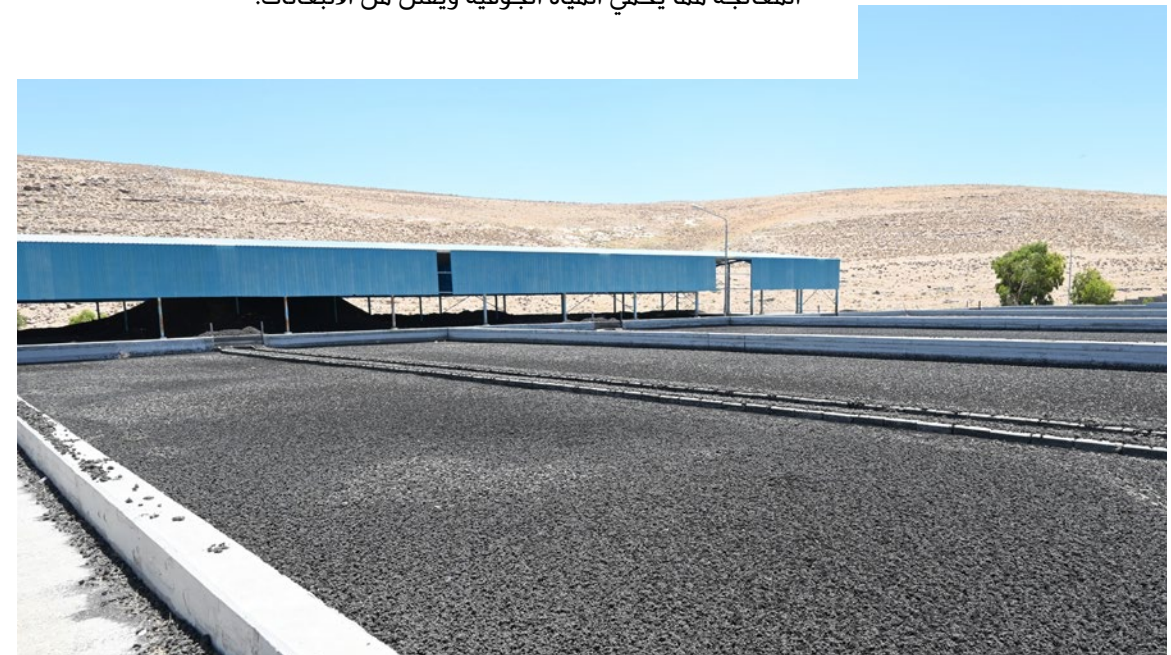
← إدارة الحمأة – محطة مؤتة والمزار لمعالجة مياه الصرف الصحي
