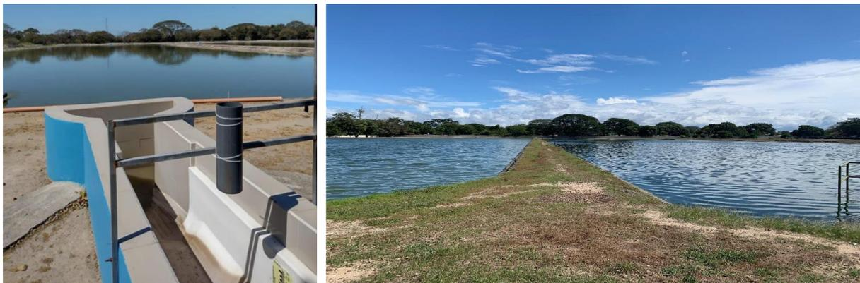
**Figura 10: Ingreso a la Planta con cajas de entrada distribuidora de caudal (izquierda), lagunas de estabilización primarias (derecha). Fuente: ROAR (2021).**
