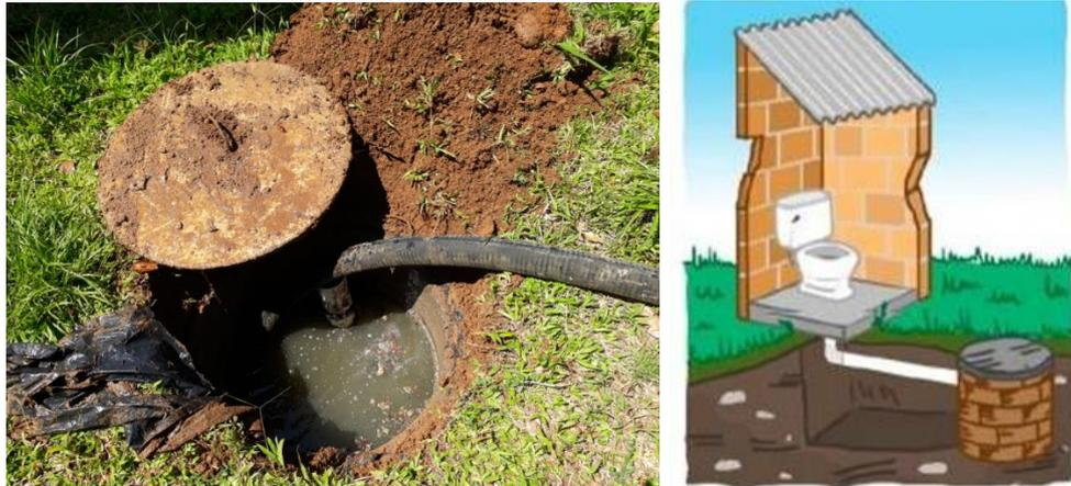
Figura 5: Tanque séptico rudimentario y esquema ilustrativo (utilizado en la encuesta georreferenciada).
