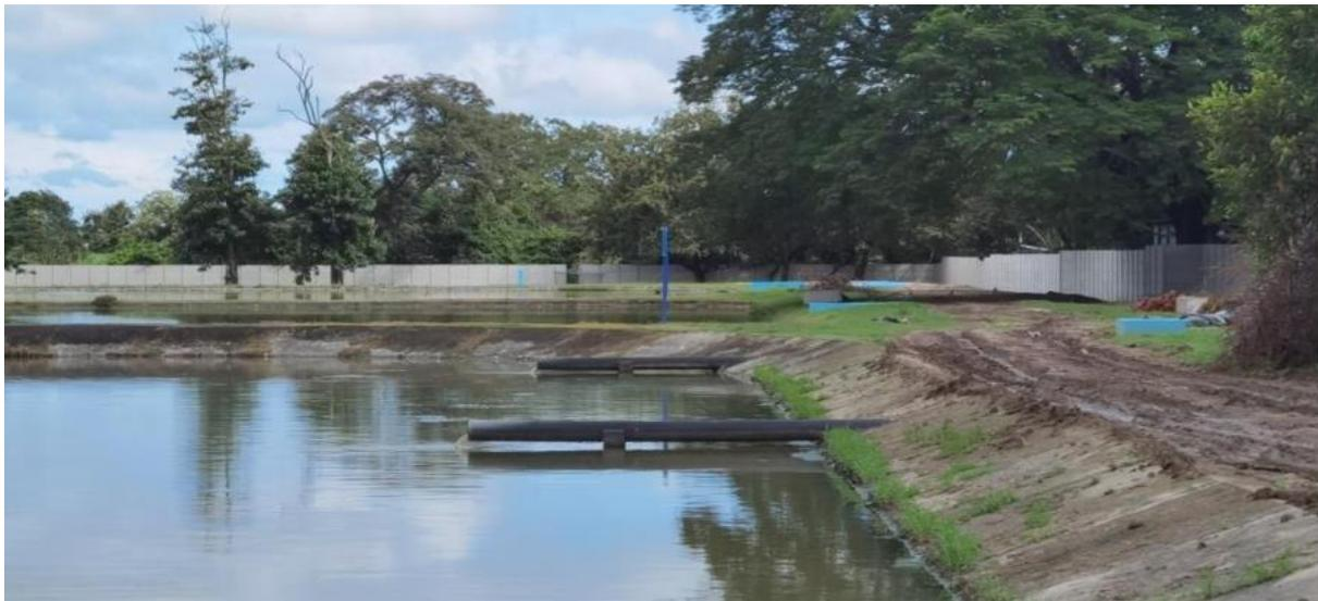
**Figura 9: Lagunas de estabilización de Liberia (primarias). Fuente: ROAR (2021).**
