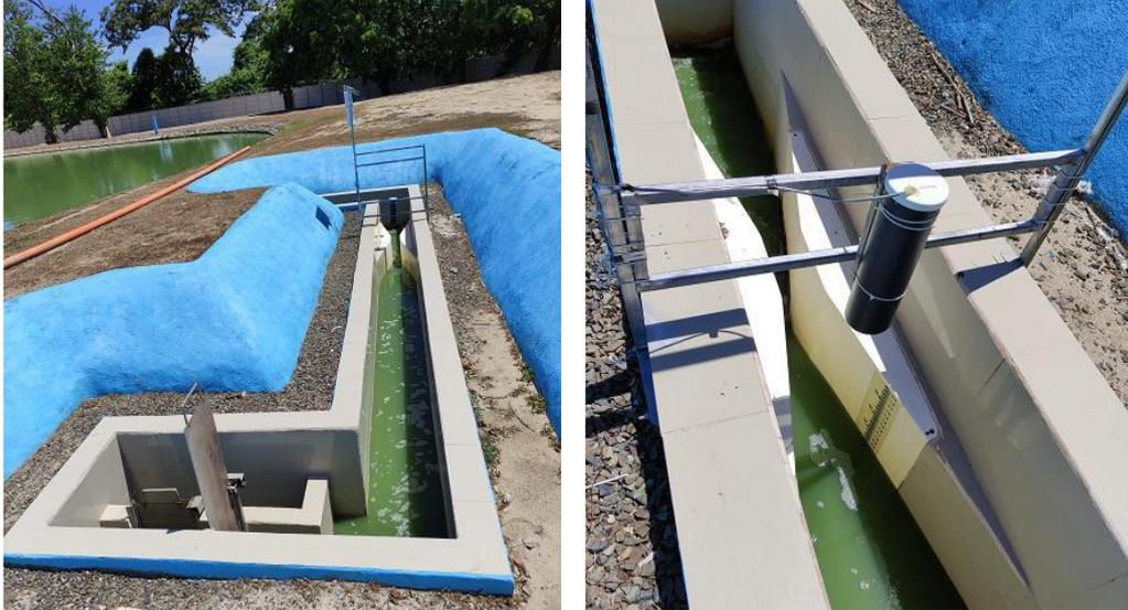
**Figura 11: Parshall de salida y medidor en línea. Fuente: ROAR (2021).**
