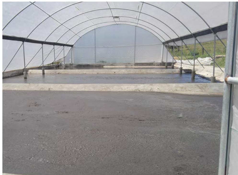
Secador solar nas instalações de NAWASSCOAL
