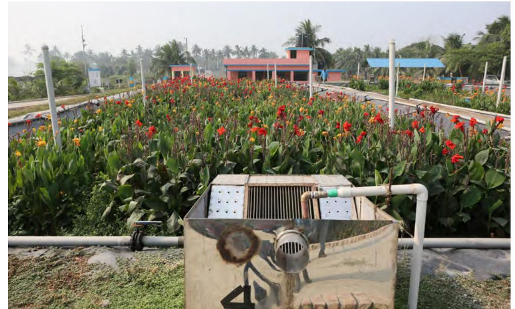
Ecrã de barra manual para remover detritos de lodo descarregadas na zona húmida de fluxo vertical construída
