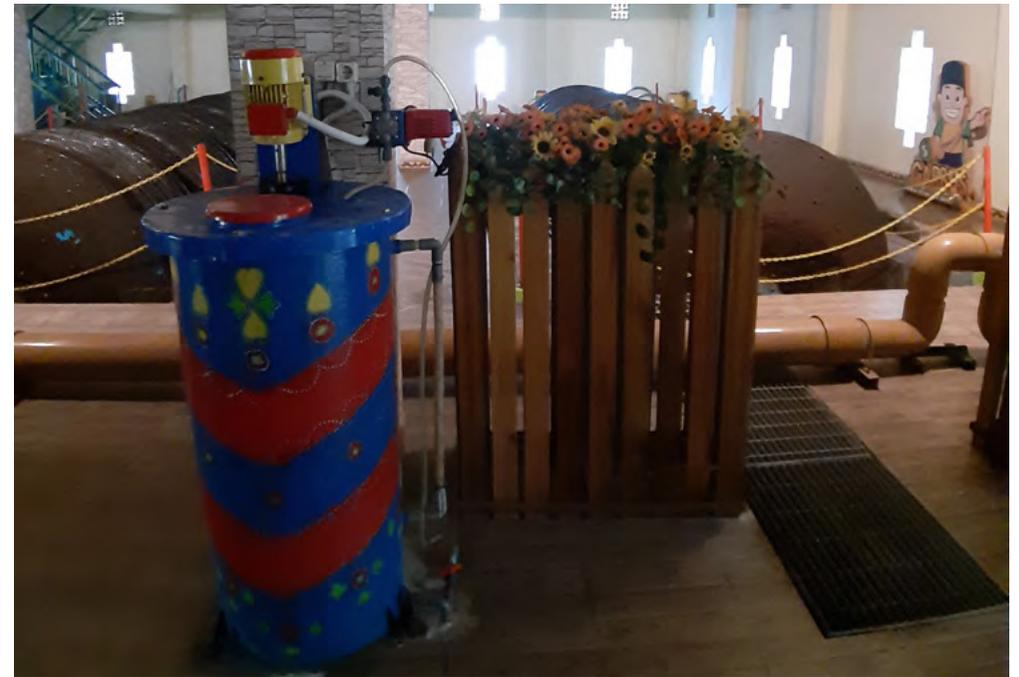
Unidad de dosificación de desinfectante, con el clarificador final por debajo de las baldosas fotografiadas
