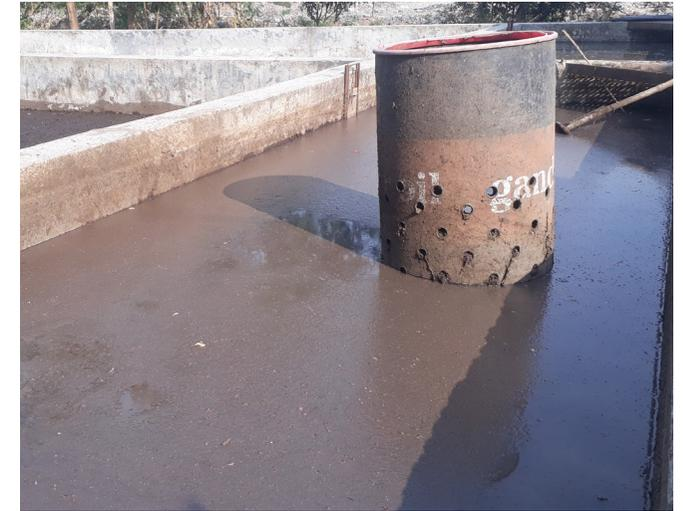
A lodo depositada passa através da porta do filtro para o leito de secagem natural
