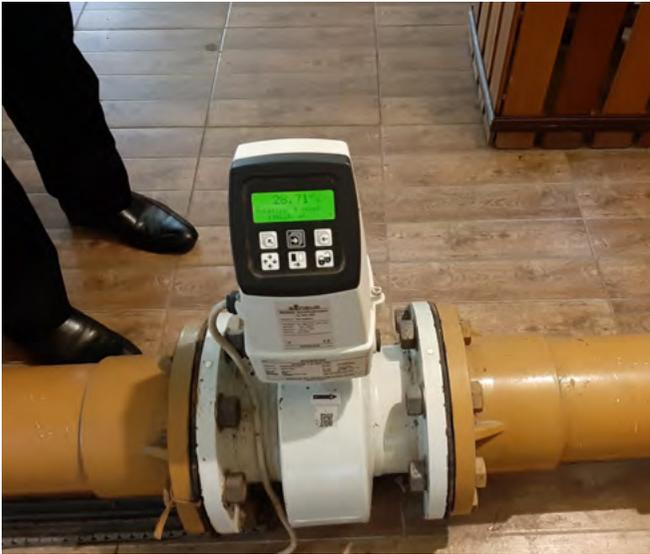
Medidor automático de fluxo de entrada
