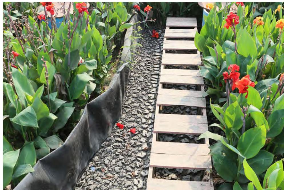
Lodo seco em áreas úmidas plantadas construídas
