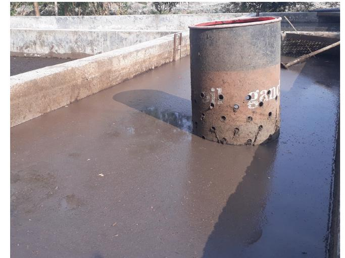
Los lodos sedimentados pasan al lecho de secado natural a través de la compuerta de filtración
