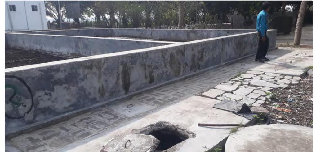
Tanques de reserva que drenan el agua de los lechos de secado de lodos
