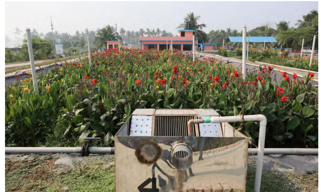
Criba manual de barras para eliminar la basura de los lodos que se vierten en el humedal construido de flujo vertical
