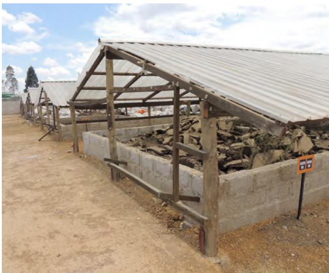
Lechos de secado de lodos techados en la FSTP de Kanyama
