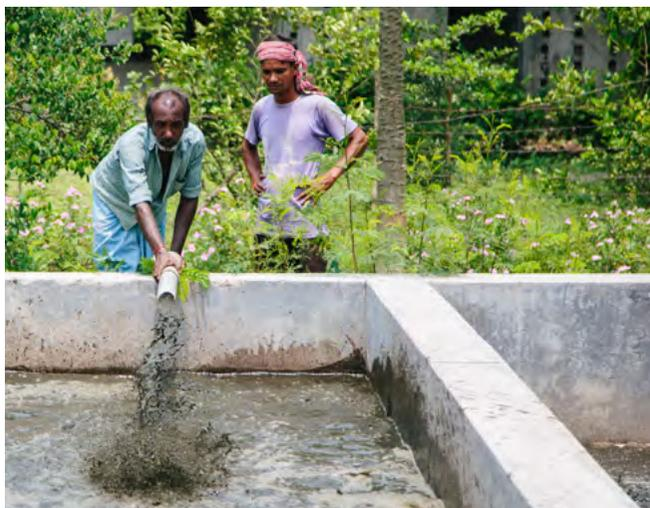
Descarga de lodos en lechos de secado
