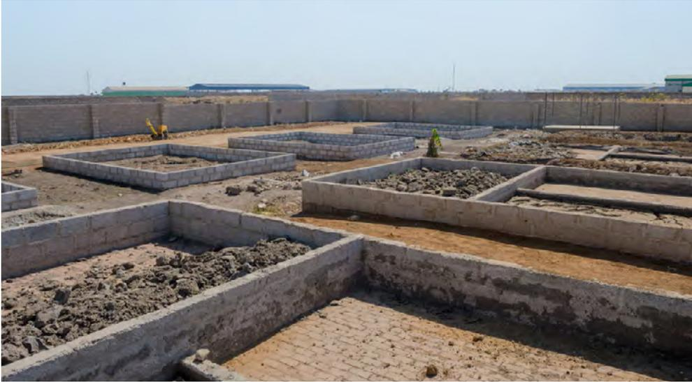
Los lechos de secado de lodos de la FSTP de Kanyama se dismantelan
