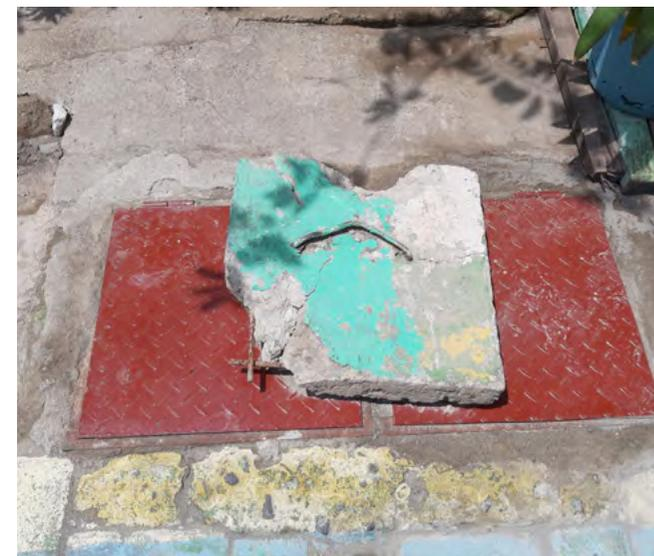
Comparación de la cubierta de hormigón y de hierro ligero para la cubierta de la cámara de inspección
