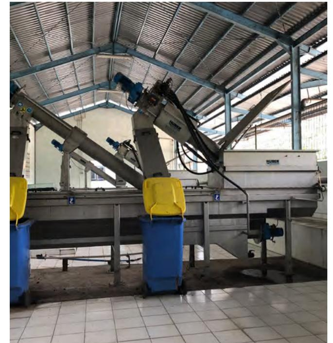
Cribado mecánico de lodos mediante planta de aceptación Huber
