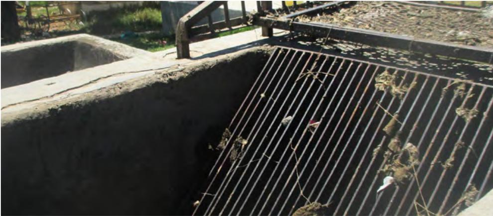
Chazanga FSTP separación de arenas en el punto de descarga del afluente
