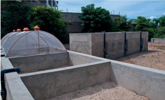
Figure 7.7 : Installation pilote à la station de traitement de Cambérène, Dakar, Sénégal, pour évaluer la déshydratation possible avec ventilation passive et active, sous serre (photo : Linda Strande).
