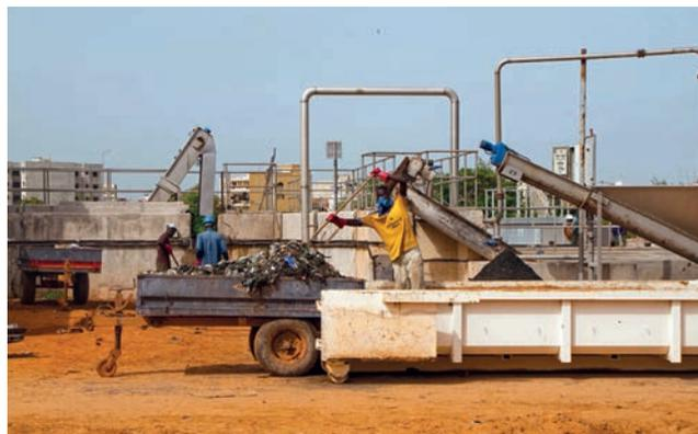
*Figure 11.1 : Un ouvrier de maintenance nettoie les dégrilleurs mécaniques ; cette activité essentielle doit être réalisée à chaque dépotage pour assurer le fonctionnement du système. Dakar, Sénégal (photo : Linda Strande).*
