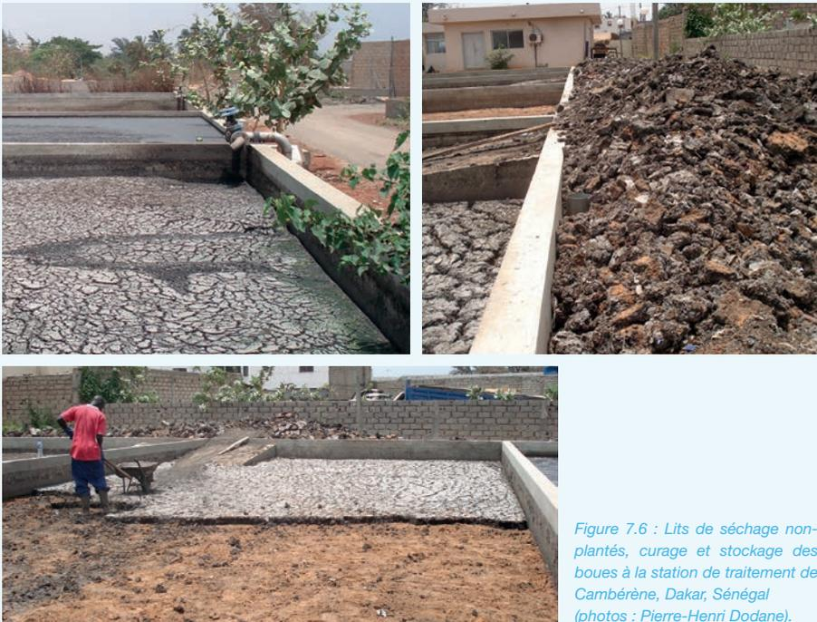
Figure 7.6 : Lits de séchage non-plantés, curage et stockage des boues à la station de traitement de Cambérène, Dakar, Sénégal (photos : Pierre-Henri Dodane).
