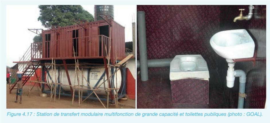
Figure 4.17 : Station de transfert modulaire multifonction de grande capacité et toilettes publiques (photo : GOAL).
