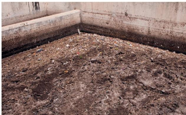
Figure 3.2 : Bassin de décantation de la station de traitement des boues de vidange de Dakar, Sénégal (photo : Linda Strande).
