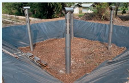
Figure 8.4 : Lit planté pilote de l'Institut asiatique de technologie avec ses colonnes de ventilation, aujourd'hui non-utilisé (photo : Linda Strande).
