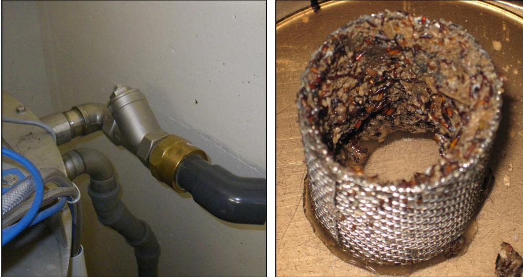
Abbildung 7: Links: Sitz des Schmutzfangs in der Urinzuleitung zum Reaktor (Foto von Matthias Hartmann, 2011). Rechts: Mit Fliegenlarven und andere im Urin enthaltene Partikeln zugesetzter Schmutzfang in der Urinzuleitung zum MAP-Reaktor (Foto von Johanna Heynemann, 2011).
