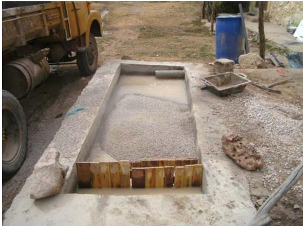
**Image 228** : Mise en place du matériau de filtre.
