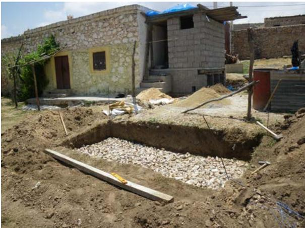
**Image 202** : Une couche horizontale de moellons forme la base pour la fondation (dalle) du filtre planté.
