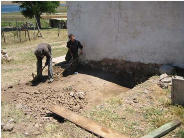
**Image 128** : Travaux d'excavation pour la fondation.
