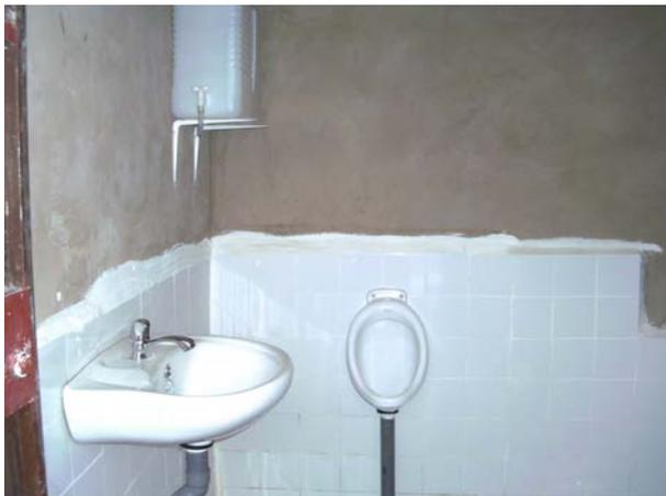
**Image 195** : Réservoir d'eau, lavabo et urinoir sont installés.
