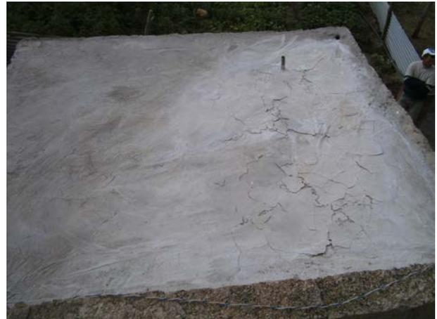
**Image 173 :** Fissures dans la superficie du toit.
