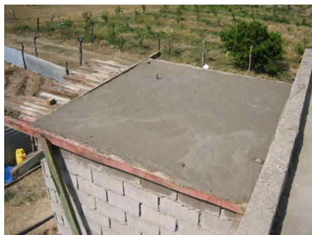
**Image 163 :** Le toit juste après la coulée du béton. On voit les garde-places pour la sortie de la cheminée et une éventuelle conduite d'eau.
