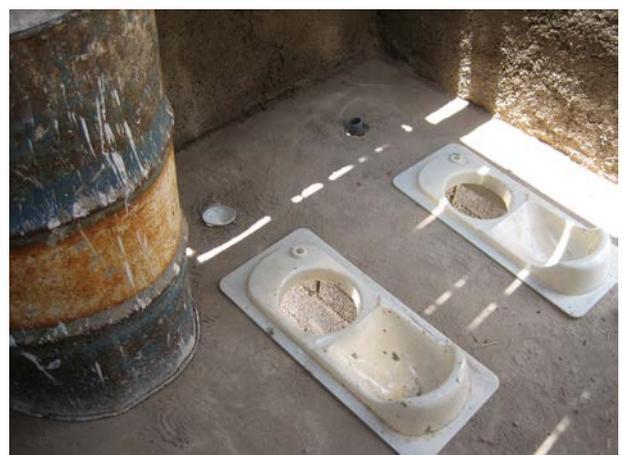
**Image 49** : Sièges de toilette (type chinois en plastique) provisoirement positionnés dans la dalle.
