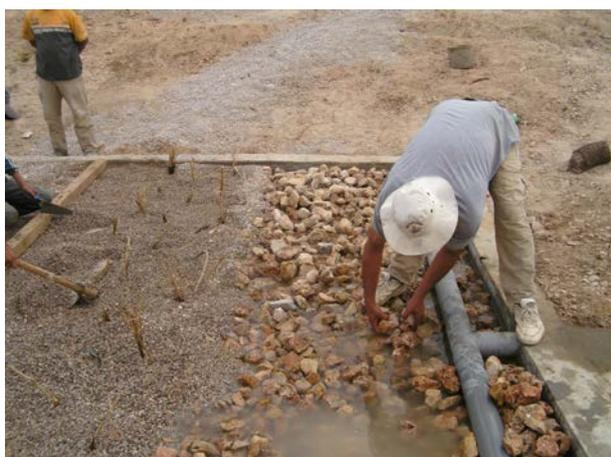
**Image 580** : Placement des galets à l'entrée du filtre.
