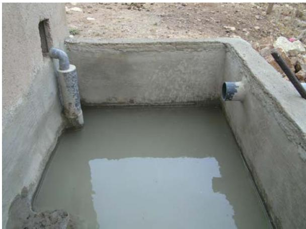
**Image 123 :** Un test d'étanchéité montre qu'il y a encore une perte d'eau.
