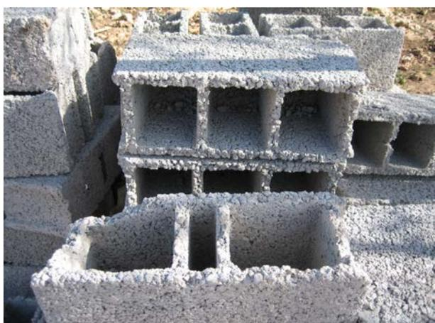
**Image 701** : Mauvaise qualité des briques (béton trop faible).
