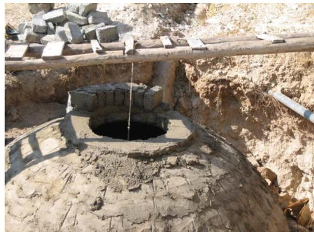
**Image 520 :** Construction de la couronne de couvercle du digesteur à l'aide d'un fil à plomb centré.
