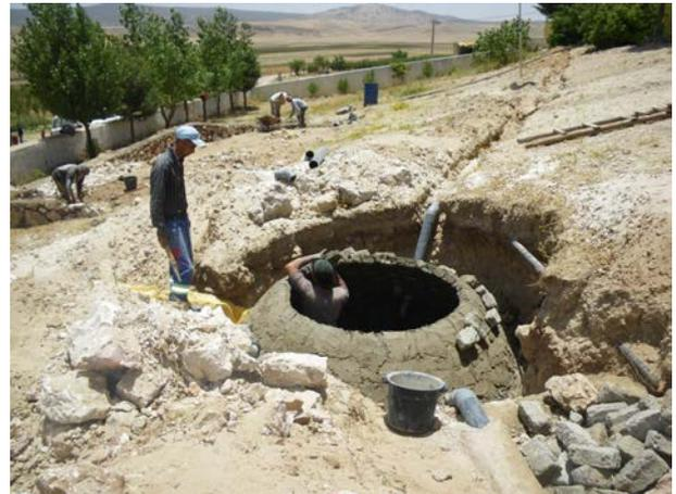
**Image 508 :** Construction du dôme du digesteur.
