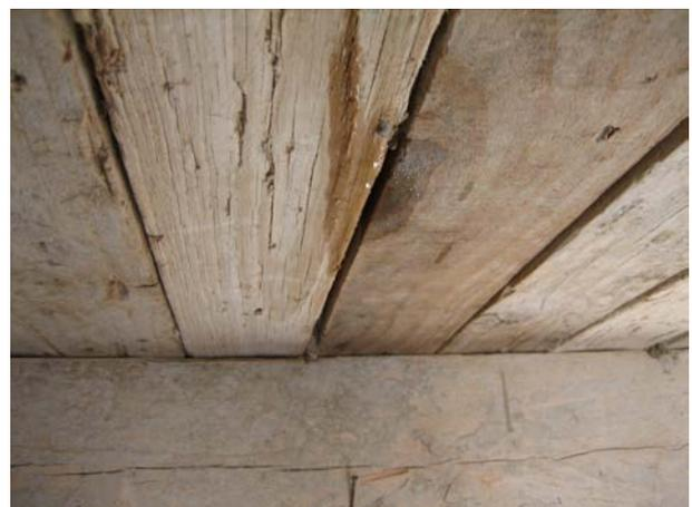
**Image 67** : Problèmes d'étanchéité du toit.
