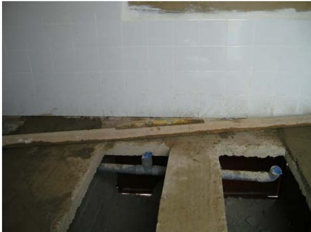
**Image 340** : Les deux refouillements pour les sièges de toilette. Les tubes visibles serviront à l'évacuation des eaux de nettoyage anal vers le puisard.
