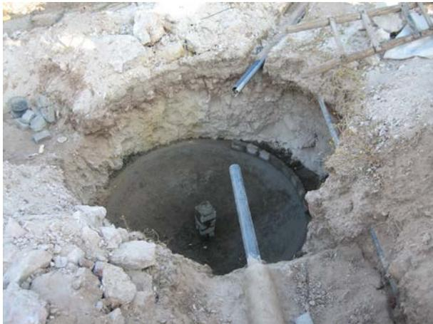
**Image 503** : Un mur provisoire de 2 briques d'épaisseur fixe le clou qui définit le centre du dôme. Les premiers blocs sont posés autour de la cuve.
