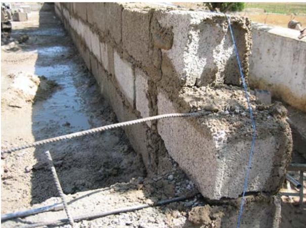
**Image 558** : Renforcement des angles par des fers à béton de 8 mm à chaque niveau de briques.
