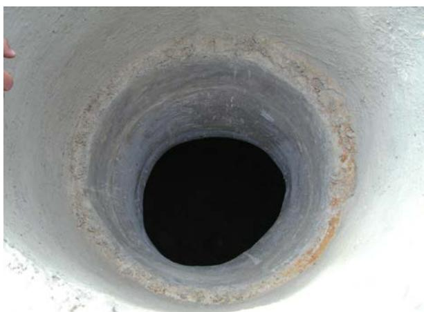
**Image 471 :** Finition de la surface intérieure de la couronne de couvercle (mortier étanche et lait de ciment).
