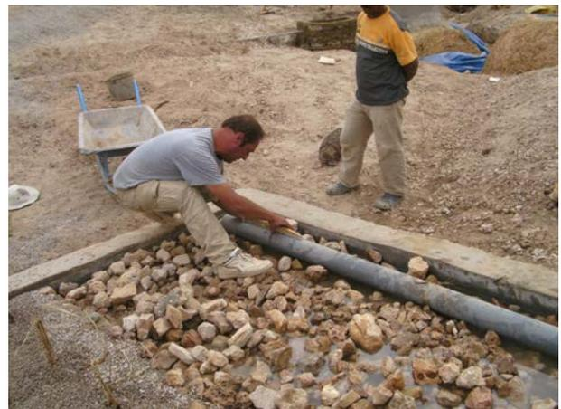
**Image 579** : Ajustement du tuyau d'alimentation.
