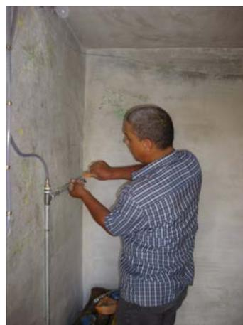
**Image 476 :** Installation d'un manomètre à eau dans la cuisine.
