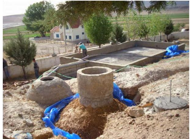
**Image 565** : La conduite du digesteur au filtre est posée. La chambre de visite à la sortie est faite.
