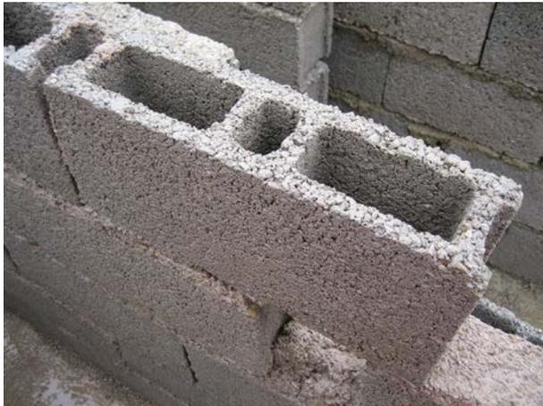
**Image 703 :** Briques (blocs) en béton 20 x 10 x 40 cm.
