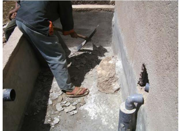
**Image 120 :** Il fallait remplacer la mauvaise couche d'enduits pour assurer l'étanchéité du bassin.
