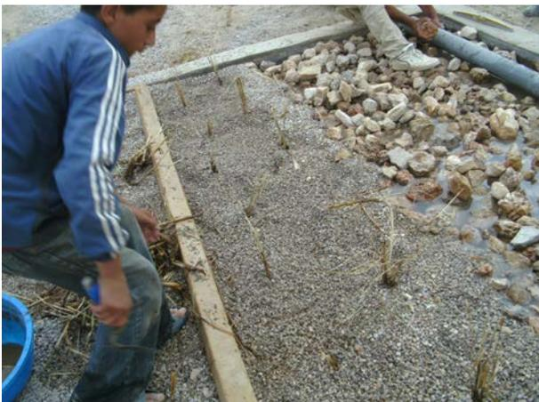
**Image 578** : Plantation du filtre. Des côtés entrée et sortie des gros graviers (moellons) ont été posés.
