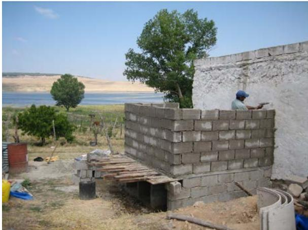
**Image 154 :** Construction des murs de la superstructure. Le maçon est en train de faire un trou dans le mur de la maison pour ancrer la TDSU par des pièces de fer rond.
