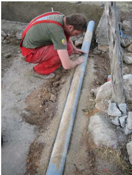
**Image 189 :** La conduite des eaux grises passe à la superficie. Elle est placée sur une couche de sable et ciment.
