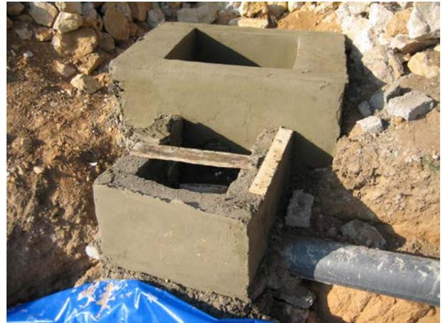
**Image 436** : Une couche d'enduit est posée.
