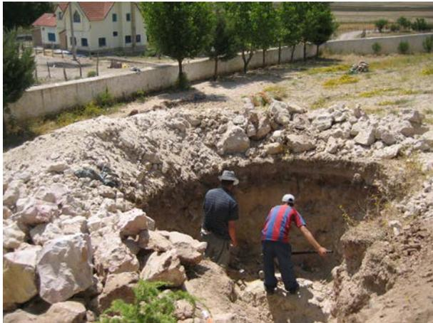
**Image 501** : Excavation de la cuve du digesteur.
