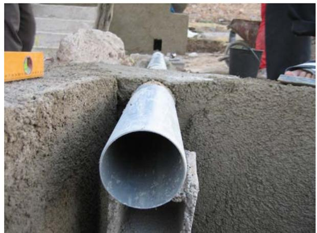
**Image 217** : Le tube d'entrée est fixé à 5 cm au-dessus du niveau d'eau. Une pente d'1 % est suffisante.
