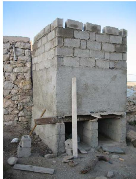
**Image 265 :** Les niches dans la dernière rangée de briques serviront à la construction du support pour le toit.
