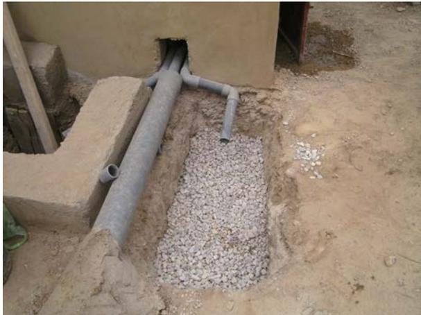
**Image 187 :** Le gravier concassé est le matériau de filtration principal dans le puisard pour les eaux de nettoyage anal.
