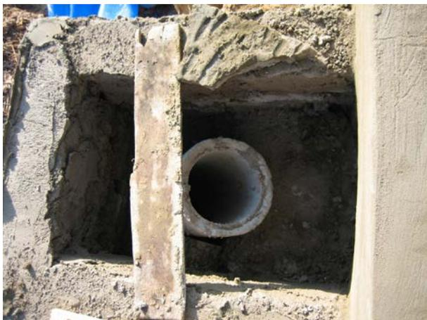
**Image 437** : Compartiment avec la buse d'alimentation et la conduite des eaux usées.
