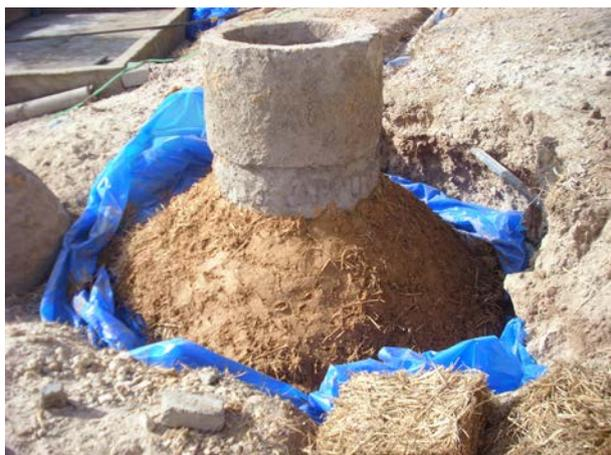
**Image 527 :** Une couche isolante d'argile et de paille est posée sur la surface extérieure du digesteur.
