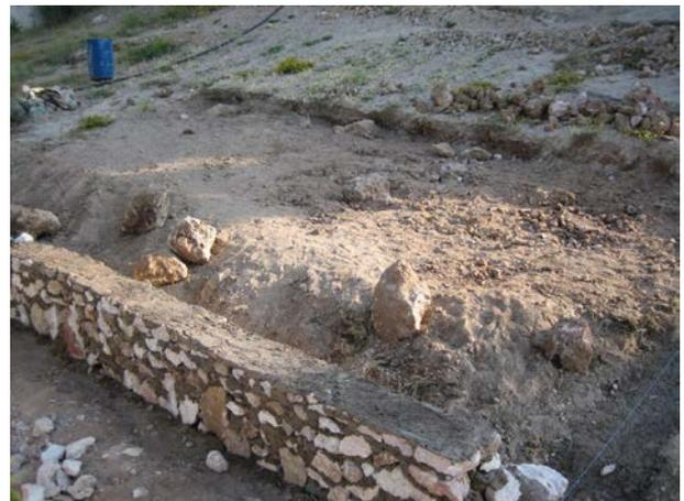
**Image 537** : Mur de soutènement du filtre végétalisé.
