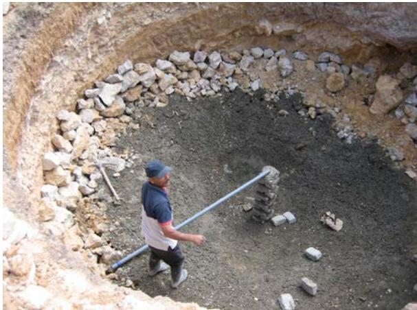
**Image 390** : Un mur provisoire de 2 briques d'épaisseur fixe le clou qui définit le centre du dôme. La baguette de mesure est à l'horizontale. Elle est utilisée pour construire le mur sphérique du dôme.
