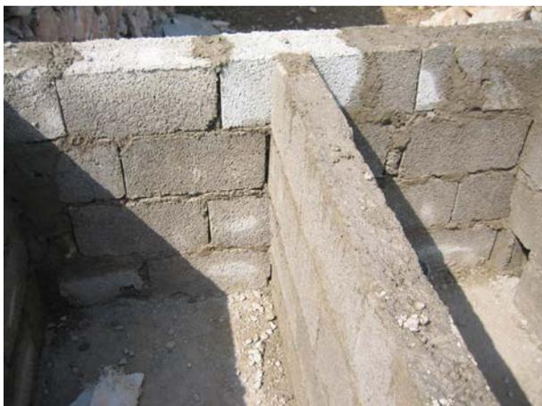
**Image 238** : Le mur intérieur qui sépare les deux fosses. A droite on voit le trou pour la sortie de la tuyauterie.
