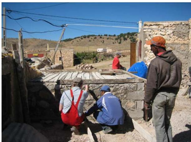
**Image 303** : Installation d'un support et coffrage pour la dalle, discussion du placement de l'escalier.
