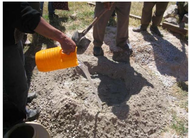
**Image 131** : Préparation du béton pour la fondation.
