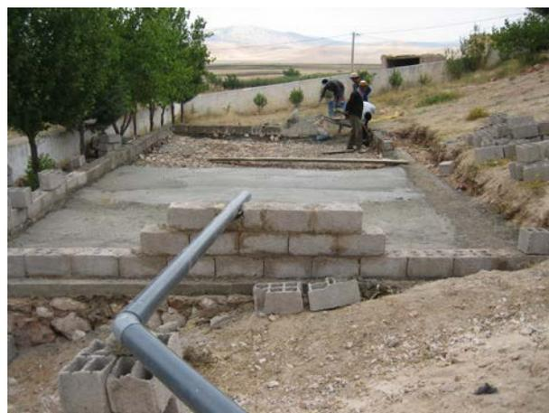
**Image 553** : Raccordement au digesteur-décanteur.
