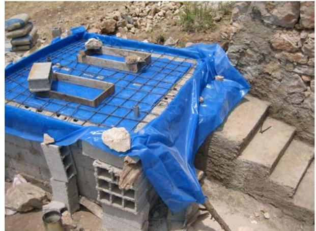
**Image 251** : Coffrage et ferrailage sont prêts. Les trous dans le plastique assureront la bonne liaison du béton de la dalle avec les murs. Des pièces de tube forment des trous dans la dalle pour la tuyauterie.
