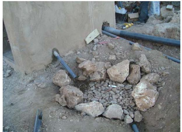
**Image 285 :** Vue extérieure de la tuyauterie et du puisard pour l'infiltration des eaux de nettoyage anal.
