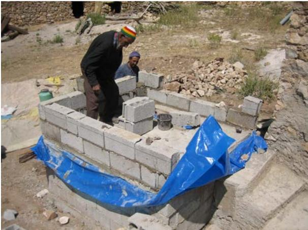
**Image 260 :** Construction des murs de la superstructure.
