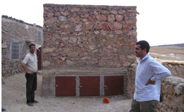
**Image 335** : La superstructure finalisée après installation des trois portes des fosses et du linteau au-dessus. Les ouvriers ont oubliés d'installer le coude pour le tuyau de ventilation.
