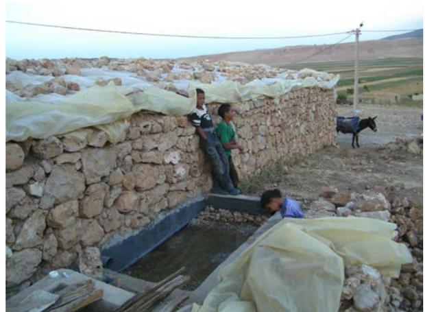
**Image 294** : Vue du filtre avec tuyau d'entrée pendant la mise en place du matériau de filtration.
