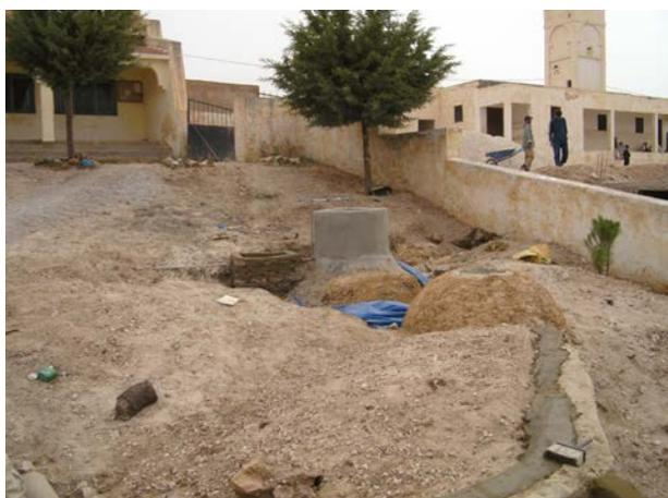
**Image 533** : Un regard du piège à eau est construit à côté du digesteur, ainsi que la protection de la conduite des eaux pré-digérées vers le filtre.
