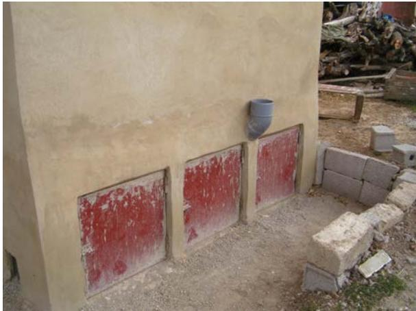
**Image 172 :** Le linteau au-dessus des portes est finalisé, le coude de 45° pour le tuyau de ventilation est placé et les enduits sont appliqués.
