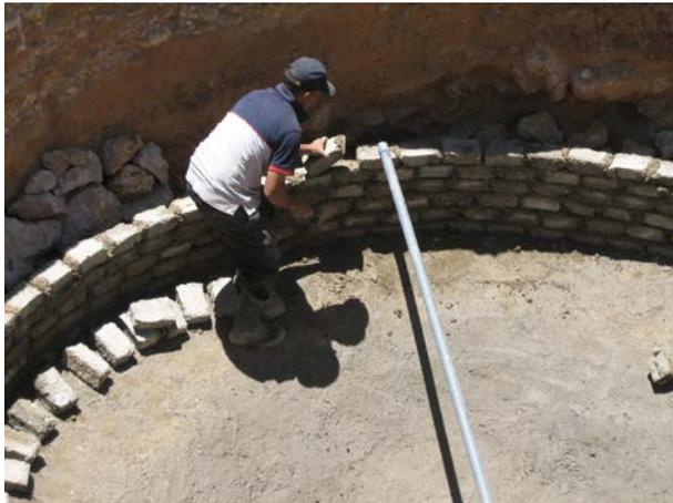
**Image 402** : Pose d'un bloc sur le mortier. Les joints sont décalés par rapport à la rangée précédente.
