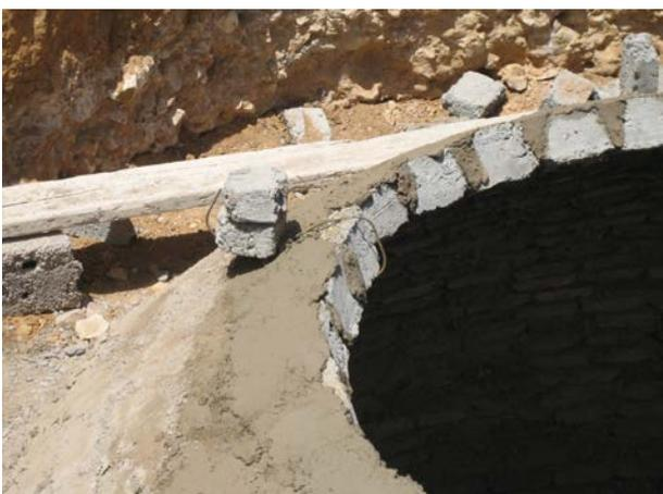
**Image 416 :** Pour les dernières rangées, l'emploi de contreponds est nécessaire pour retenir la première brique d'une rangée et l'avant-dernière qui vient d'être placée.
