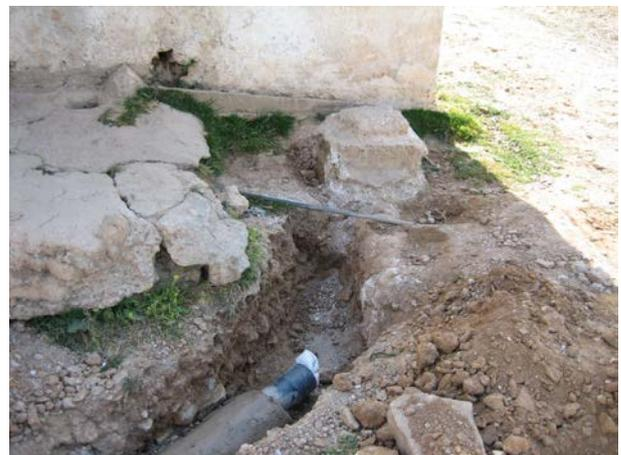
**Image 486** : Le puits perdu de la mosquée, où la conduite sera raccordée. Le trou et la rigole visible au mur est la sortie des eaux grises.
