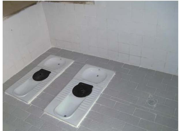
**Image 198** : Les deux sièges à séparation d'urine et le siphon de sol de la douche.
