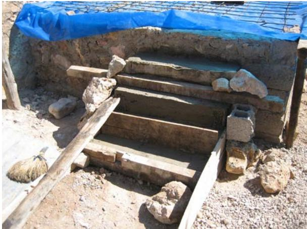
**Image 315** : Coffrage pour bétonner l'escalier.
