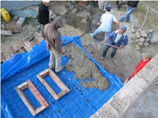
**Image 145 :** Distribution du béton. Des trous dans le plastique assurent la liaison de la dalle avec les murs des fosses.
