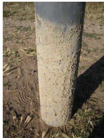
**Image 209** : Avant d'installer les tubes d'entrée et de sortie une couche de colle PVC et du sable est appliquée. Cela assurera la liaison avec le mortier du mur et donc une bonne étanchéité.
