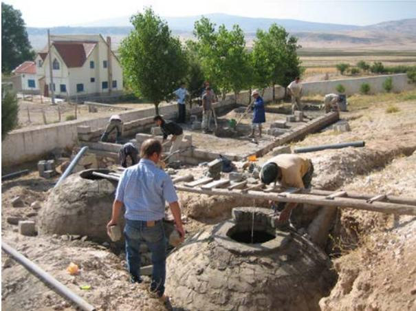
**Image 554** : Pose de la 2<sup>ème</sup> rangée de briques des parois du filtre.
