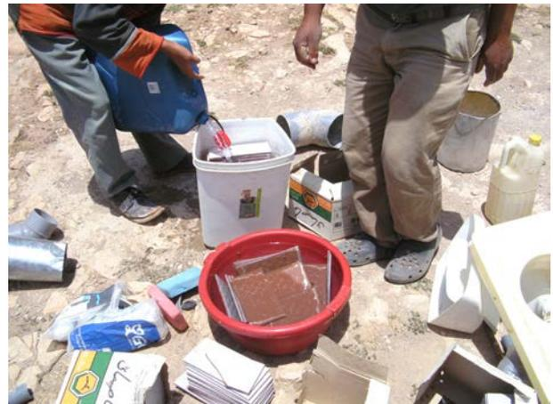
**Image 101** : Mouillage du carrelage avant la pose.
