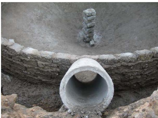
**Image 406** : Vue de la buse du bassin d'expansion et du centre du digesteur.
