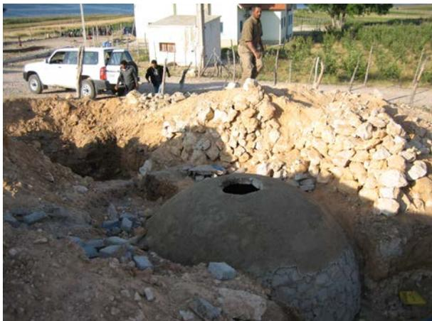
**Image 446** : Les rangées de briques sont montées jusqu' à obtenir un trou au sommet de 60 cm de diamètre. Une couche de béton est posée à l'extérieur.
