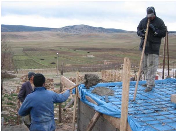
**Image 40** : Le béton est distribué sur le support et lissé à l'aide d'une planche.
