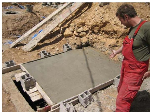
**Image 467** : Le couvercle en béton armé est coulé.
