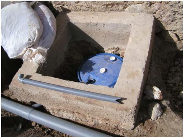
**Image 352** : Réservoir d'urine avec tuyau plongeur.
