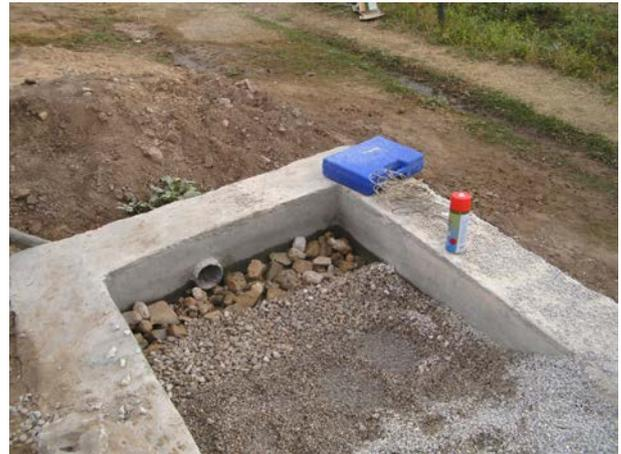
**Image 229** : La zone de drainage avec ses 3 tailles de grain.
