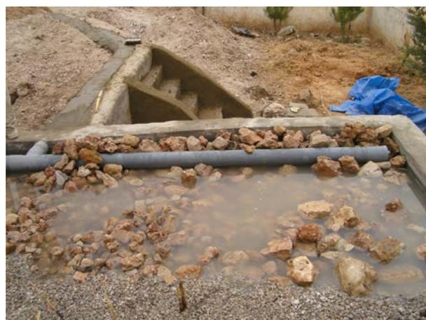
**Image 581** : Le tuyau d'alimentation est ajusté à l'horizontale.
