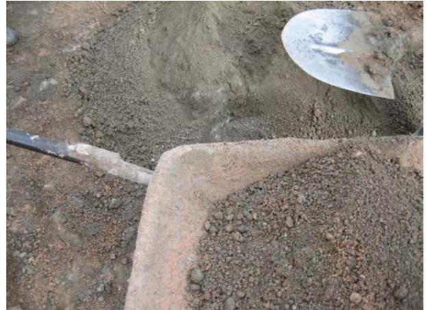
**Image 39** : Préparation du béton pour la dalle.
