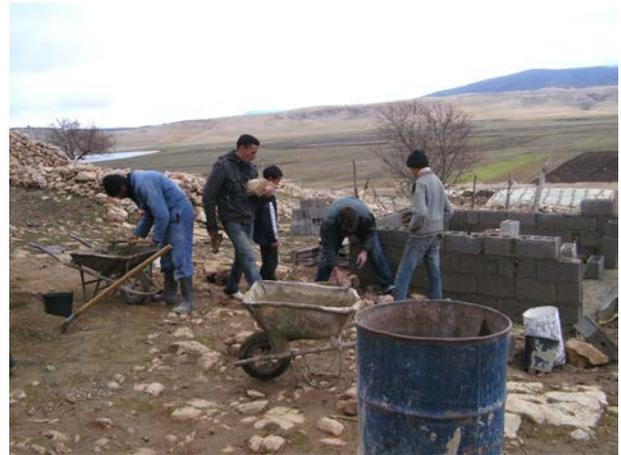
**Image 27 :** Préparation du mortier dans une brouette et collecte de pierres pour l'escalier.
