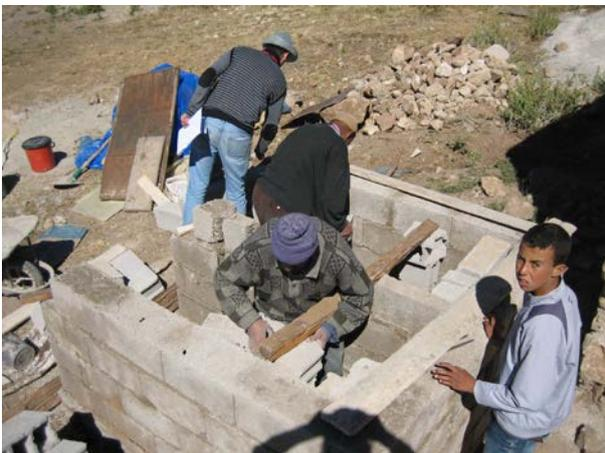
**Image 242** : Installation du support pour la dalle.
