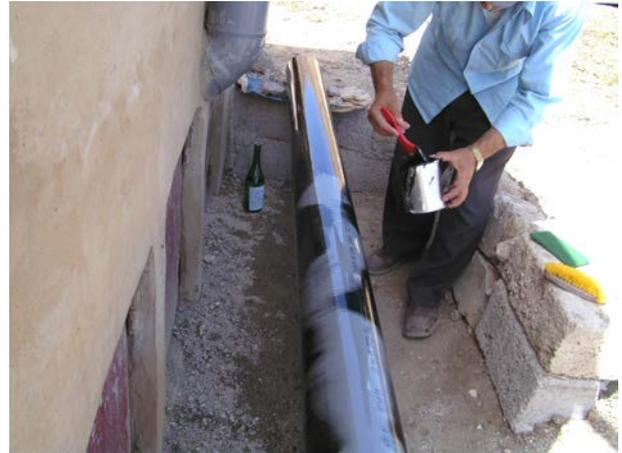
**Image 176 :** La peinture noire sur le tuyau de ventilation cause un chauffage solaire augmenté, ce qui supporte le courant d'air.
