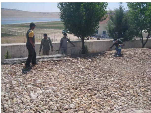
**Image 548** : Pose de béton au bord du filtre.
