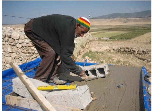
**Image 253** : Distribution du béton avec la truelle.
