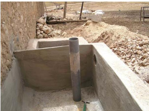
**Image 366** : le tube de sortie avant son placement.
