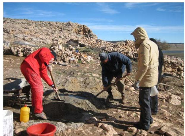
**Image 19 :** Le béton est gâché à la main à cause d'absence d'une bétonneuse.
