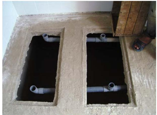
**Image 178 :** Les deux refouillements pour les sièges de toilette. Les tubes à l'avant seront pour l'urine, et ceux en arrière pour les eaux de nettoyage anal.
