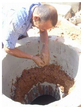
**Image 472 :** Application d'un lit d'argile (avec un peu de chaux, ciment et eau) sur le cône du couvercle.
