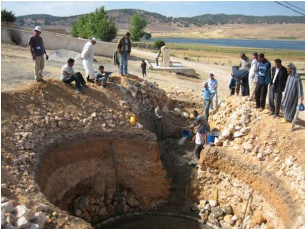
**Image 392** : Préparation du béton pour le radier.
