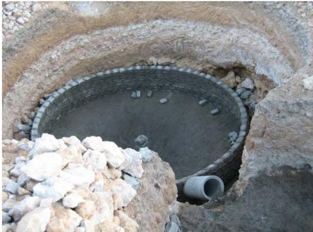
**Image 408 :** La cuve du digesteur en construction.
