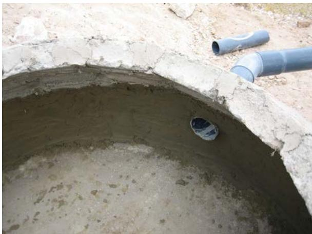
**Image 519 :** Sortie des eaux prétraitées du bassin d'expansion.
