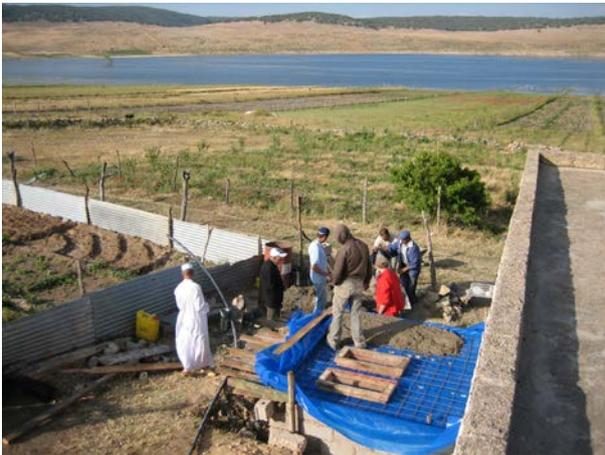
**Image 147 :** Vue du chantier et du lac pendant la coulée de la dalle.
