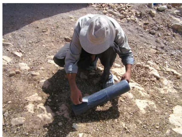
**Image 290** : Application de la colle PVC et du sable sur le tuyau de l'effluent.
