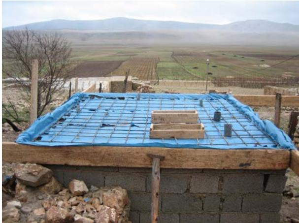
**Image 38** : Coffrage et ferrailage avec cadres finalisés.
