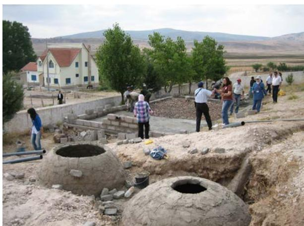
**Image 550** : Pose de la dalle de fond. Simultanément la première rangée de briques est posée par les participants de l'atelier de construction.
