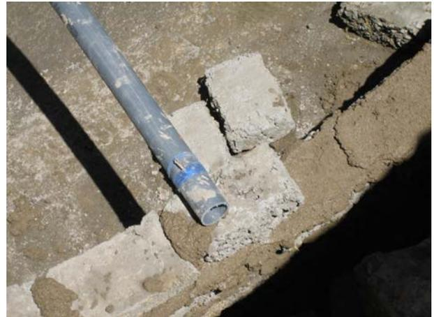
**Image 397 :** Positionnement radial des blocs à l'aide de la baguette de mesure. Il faut bien remplir les joints de mortier.
