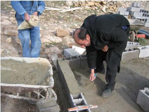
**Image 26 :** Les briques ont été remplies de cailloux et mortier pour fortifier les murs des fosses.
