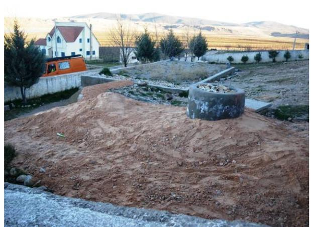
**Image 587** : Remblaiement du digesteur et des conduites.
