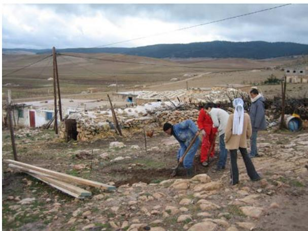
**Image 14** : Travaux d'excavation pour la fondation.
