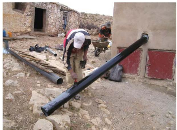
**Image 89** : La peinture noire sur le tuyau de ventilation cause un chauffage solaire augmenté, ce qui supporte le courant d'air.
