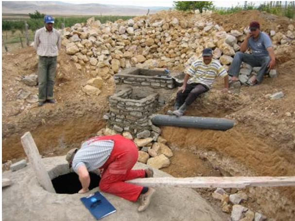
**Image 435** : L'arrivée des eaux usées est connectée à la buse d'alimentation.
