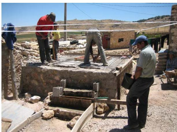
**Image 305** : Construction de l'escalier et préparation du ferrailage.
