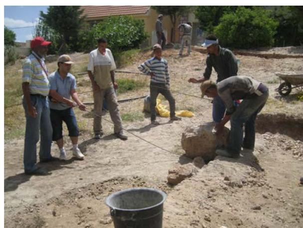
**Image 543** : Les participants de l'atelier de construction aident à préparer des fers à béton pour la dalle du filtre planté.
