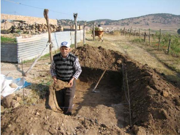
**Image 200** : Travaux d'excavation pour le filtre planté.
