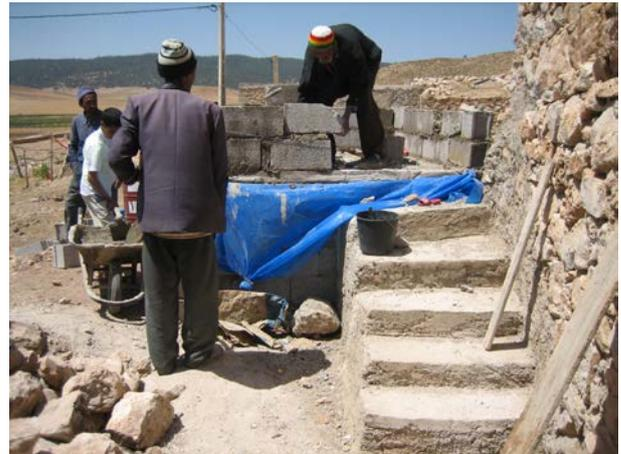
**Image 261 :** Construction des murs de la superstructure.
