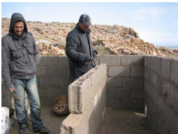
**Image 30 :** Construction des murs de séparation. En bas on voit le trou de sortie prévu pour la tuyauterie.
