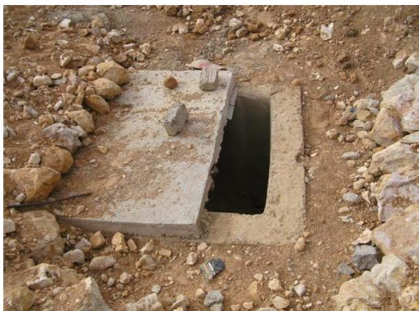
**Image 468** : Ouverture pour la vidange des effluents digérées.
