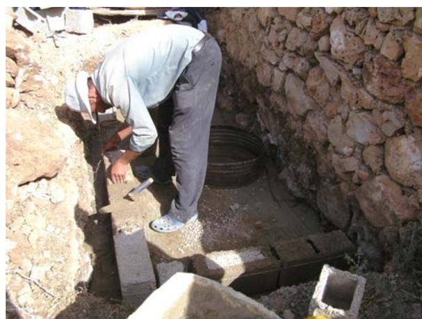
**Image 288** : Maçonnerie sur la dalle du filtre.
