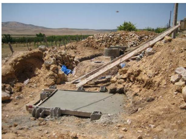
**Image 466** : Le couvercle en béton armé est coulé.
