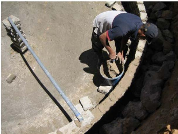
**Image 398 :** Une couche de mortier est posée.
