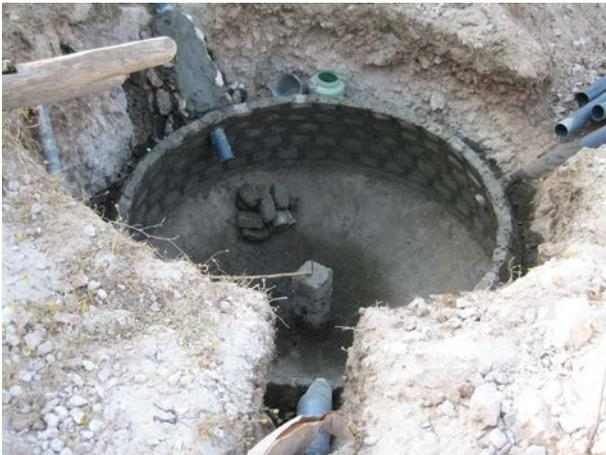
**Image 507 :** Vue du dôme du digesteur en construction.
