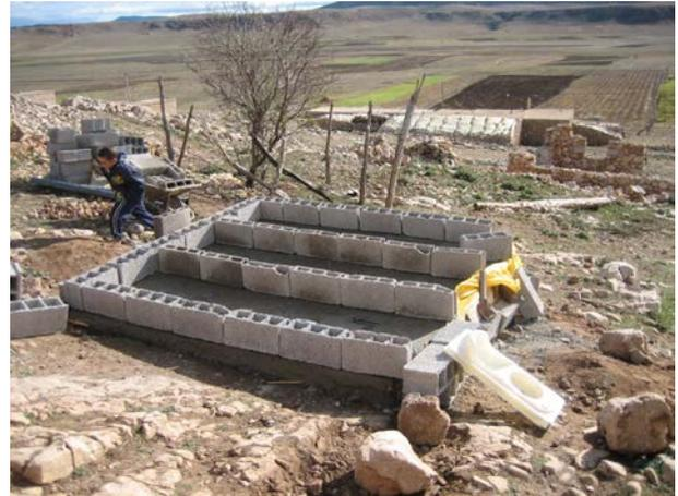
**Image 25 :** Les fosses ont trois compartiments (deux pour la matière fécale et une pour la sortie de la tuyauterie et le stockage d'accessoires).
