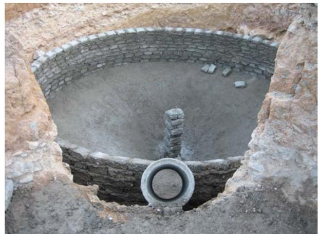
**Image 405** : Vue de la buse du bassin d'expansion et de la cuve du digesteur.
