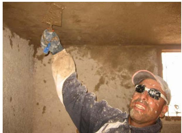
**Image 73** : Application d'une 2<sup>ème</sup> couche d'enduits au toit.
