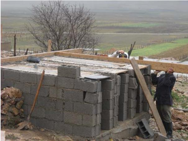
**Image 32** : Préparation du coffrage pour la dalle, supporté par des briques positionnées à l'intérieur des fosses.
