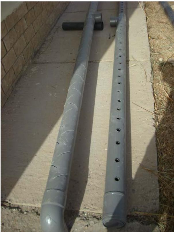
**Image 572** : Préparation des tuyaux d'alimentation et de sortie.
