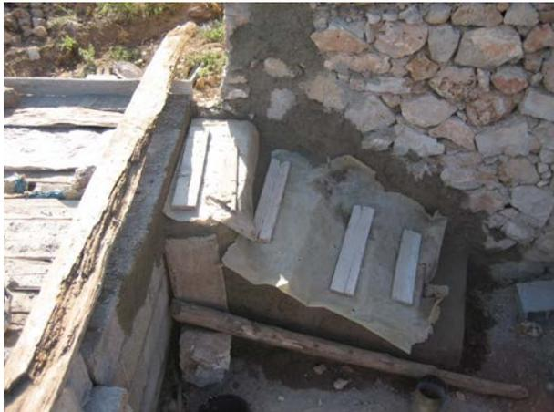
**Image 248** : L'escalier finalisé est couvert pendant le séchage.
