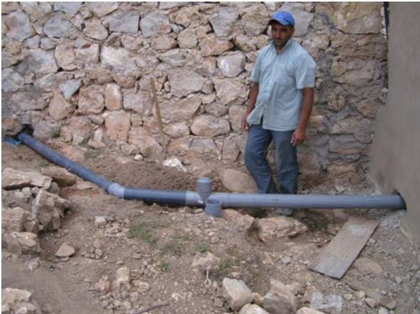
**Image 282 :** La conduite des eaux grises de la maison passe par le bâtiment de la toilette vers le filtre planté.
