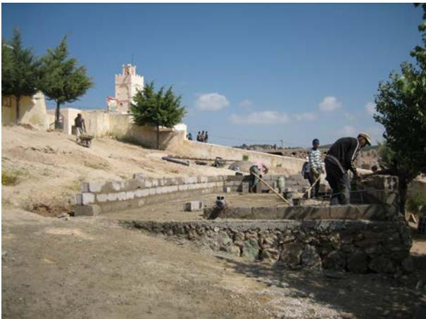
**Image 556** : Construction des parois du filtre planté.
