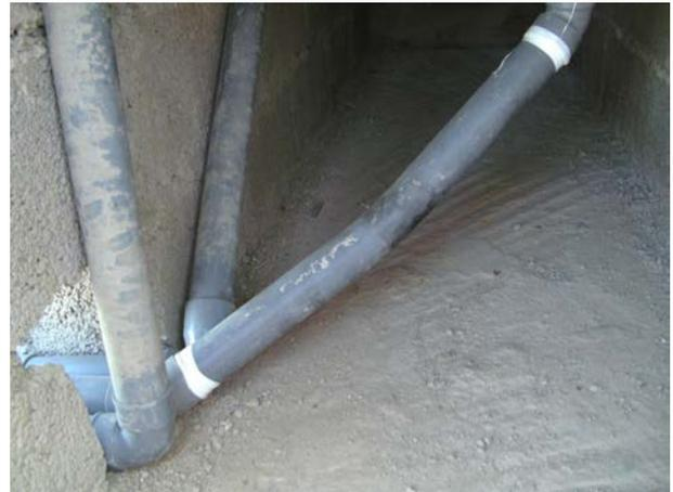
**Image 182** : Sortie des trois conduites pour eaux grises lavabo/douche, urine et eaux de nettoyage anal (placement provisoire).
