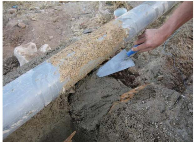
**Image 215** : Mise en place du tube d'entrée.
