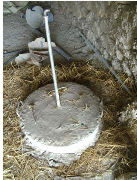
**Image 470** : Couvercle du digesteur avec quatre poignées et tuyau galvanisé.
