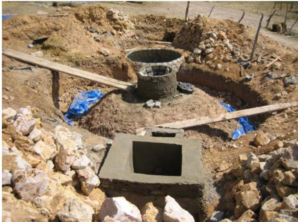
**Image 456 :** Le chantier pendant la construction de la couronne de couvercle et du bassin d'expansion.
