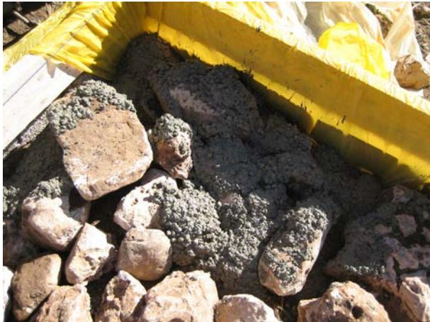
Image 20 : Le béton est coulé entre les pierres.
