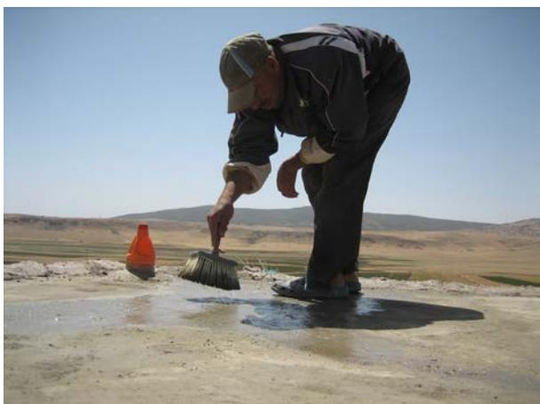
**Image 66** : Arrosage du toit pour prévenir des fissures. Une bouteille couvre la sortie de la cheminée.
