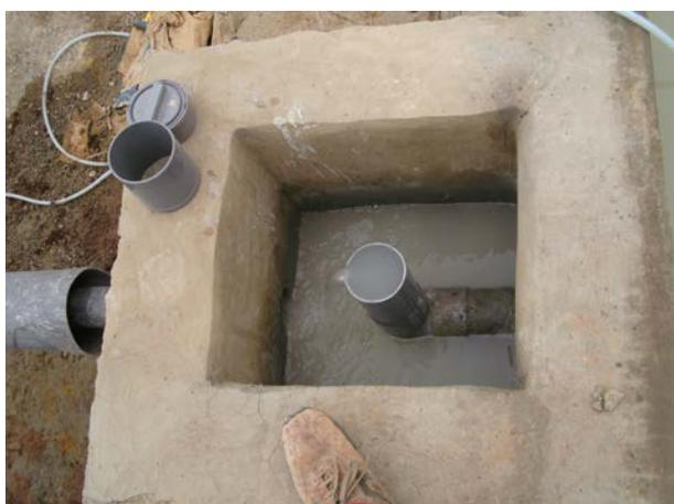
**Image 582** : Chambre de visite à la sortie des eaux épurées. En changeant la position (l'angle) du tuyau vertical le niveau d'eau dans le filtre peut être ajusté.
