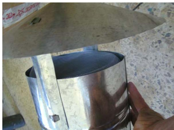
**Image 712** : Moustiquaire placé sous le chapeau au bout du tuyau de ventilation.
