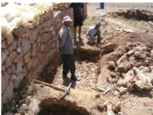
**Image 287** : Une couche horizontale de moellons est placée dans l'excavation finalisée. En bas on voit l'excavation ronde pour le réservoir d'urine.
