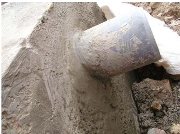
**Image 370** : Le tuyau de sortie est intégré dans le mur du bassin.
