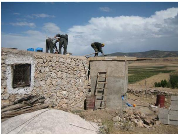
**Image 274 :** Coulée du toit en béton
