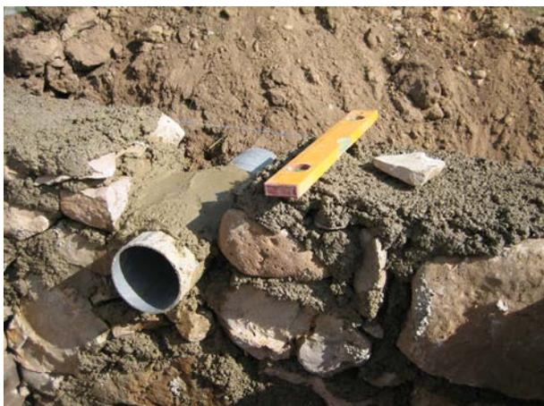
**Image 210** : Pose du tuyau de sortie.
