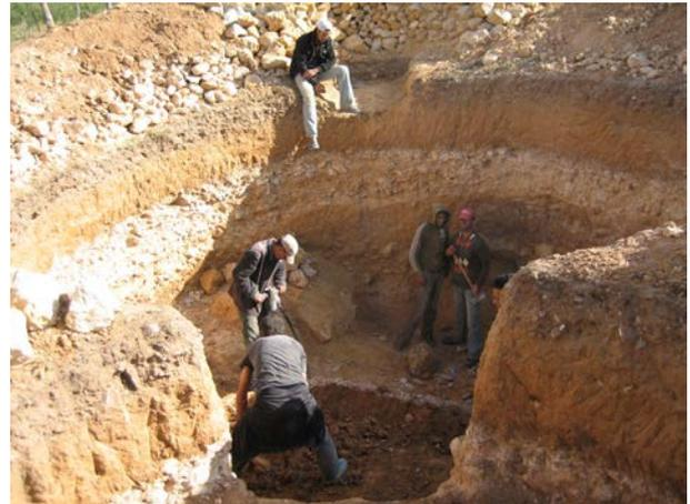
**Image 380 :** Travaux d'excavation à l'aide du marteau pneumatique.
