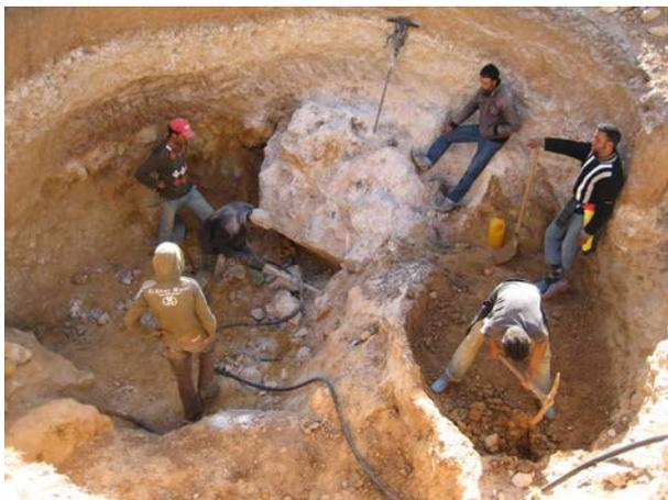
**Image 381 :** Travaux d'excavation à l'aide du marteau pneumatique.
