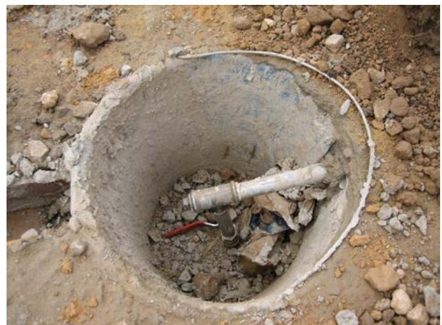
**Image 443** : Construction d'un regard à l'aide d'un seau.
