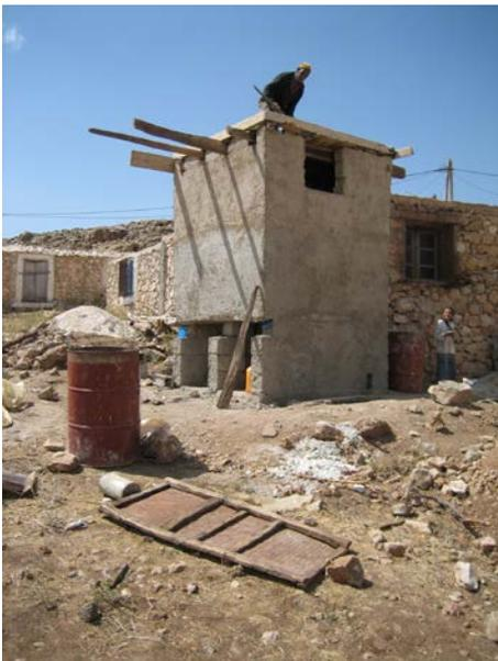
**Image 270** : Installation du coffrage pour le toit.
