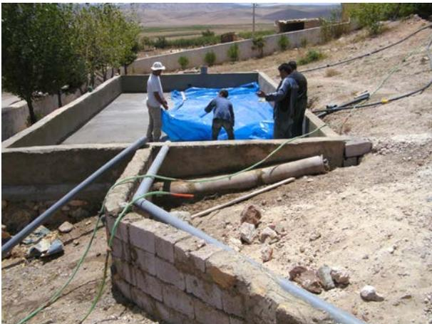
**Image 566** : Placement d'un plastique au fond du bassin.
