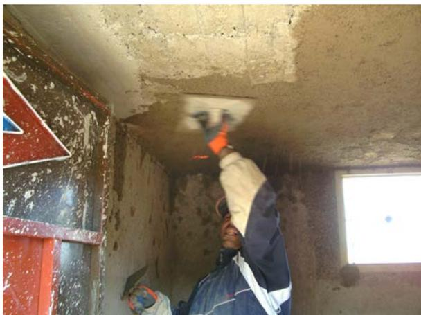
**Image 72** : Application d'une couche d'enduits à la partie inférieure du toit. La porte est déjà installée.
