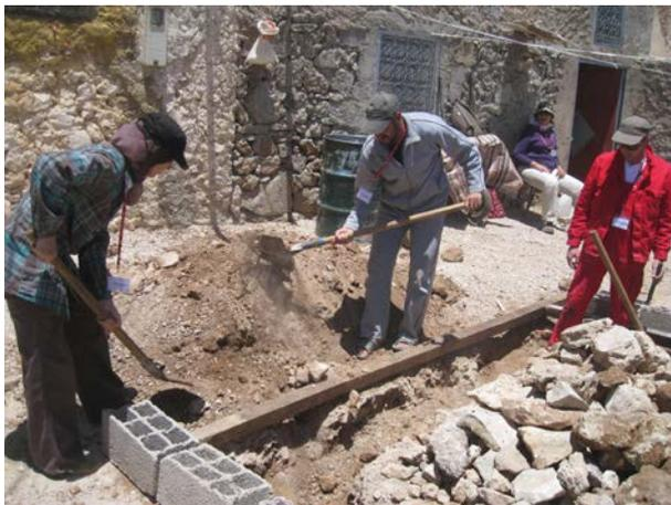
**Image 295** : Travaux d'excavation pour la fondation.
