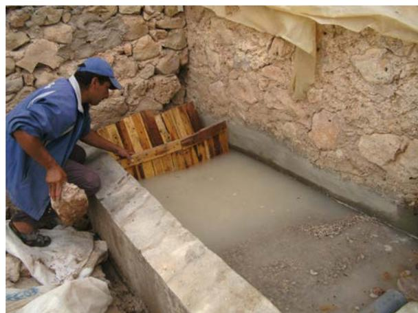
**Image 371** : Avec des planches à la zone de l'entrée, les 3 différentes tailles du grain sont séparées pendant le placement du matériau de filtre.
