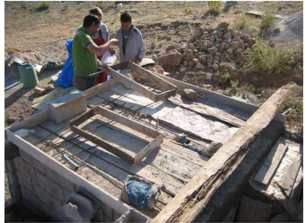
**Image 247** : Préparation du ferrillage autour des deux cadres.
