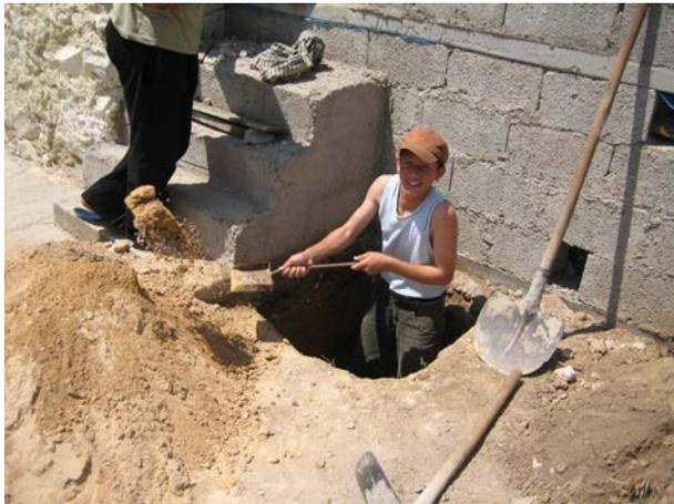
**Image 183** : Excavation pour le réservoir d'urine.
