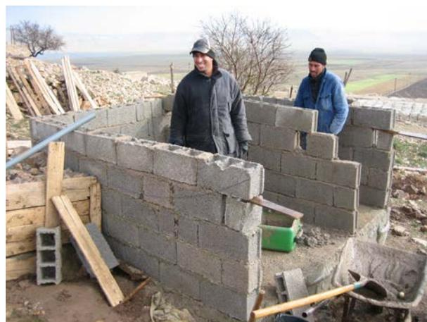
**Image 31 :** Une niche est prévue pour le linteau de baie et le tuyau de ventilation, ainsi qu'un trou pour les tuyaux.
