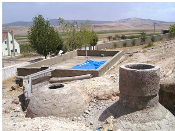
**Image 524 :** Digesteur et bassin d'expansion après séchage (juillet 2010).
