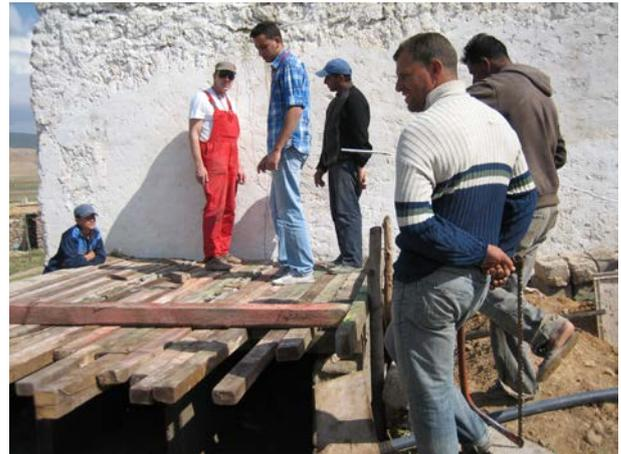
**Image 140** : Installation d'un coffrage pour la dalle.
