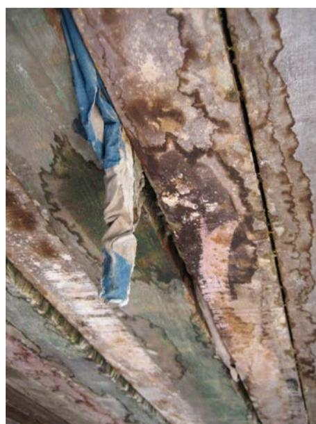
**Image 165 :** Au lieu d'un plastique les maçons ont utilisé des emballages du ciment pour étancher. Par conséquent, il y avait quelques pertes de la partie liquide du béton.
