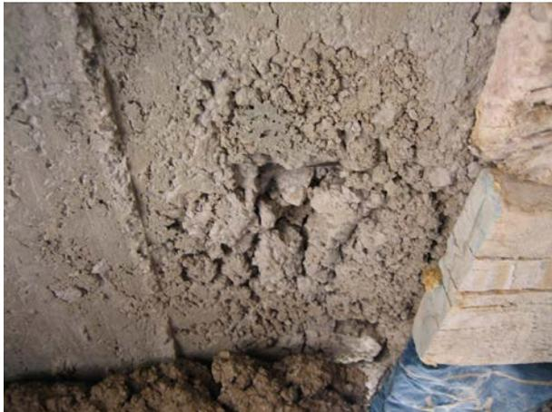
**Image 68** : Cavités et fissures dans le béton du toit.
