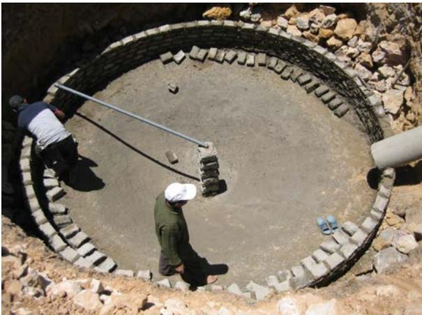
**Image 394** : Construction des premières rangées de briques. La buse du bassin d'expansion est déjà posée.
