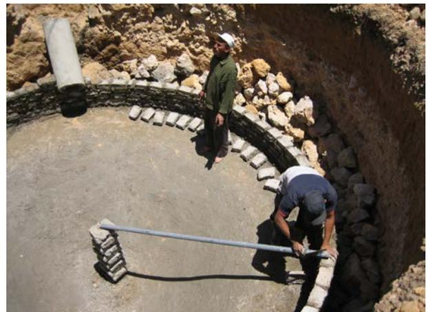
**Image 401 :** La brique est placée à l'aide de la baguette de mesure. La baguette est à la perpendiculaire de la longueur de la brique. Le dessus de la brique est toujours parallèle à la baguette.
