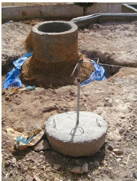
**Image 531** : Couvercle du digesteur avec quatre poignées et tuyau galvanisé.
