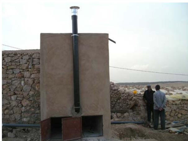
**Image 281 :** Tuyau de ventilation, tuyau pour l'évacuation des eaux de pluie et portes des fosses sont installés.
