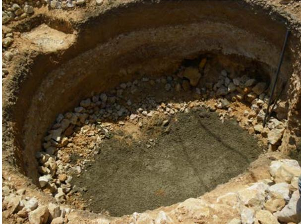
**Image 388** : Bétonnage du fond (radier) de la cuve.
