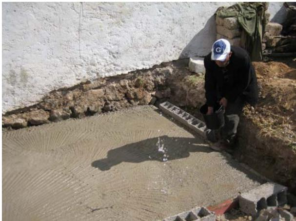
**Image 134** : Irrigation du béton frais.
