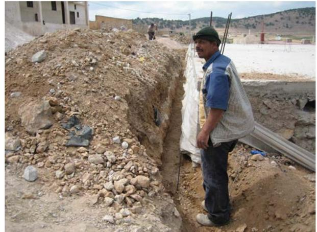
**Image 484** : Tranchée pour le tuyau des eaux usées.
