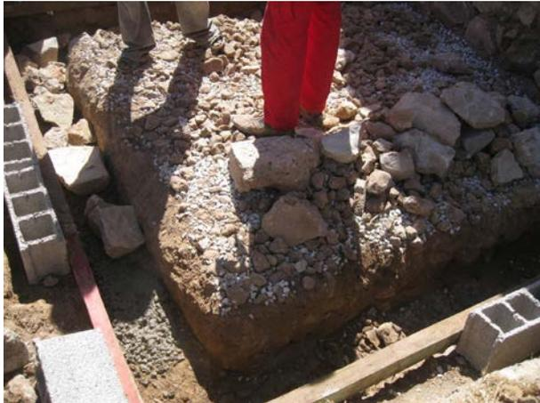
**Image 132** : Des pierres sont utilisées dans la fondation.
