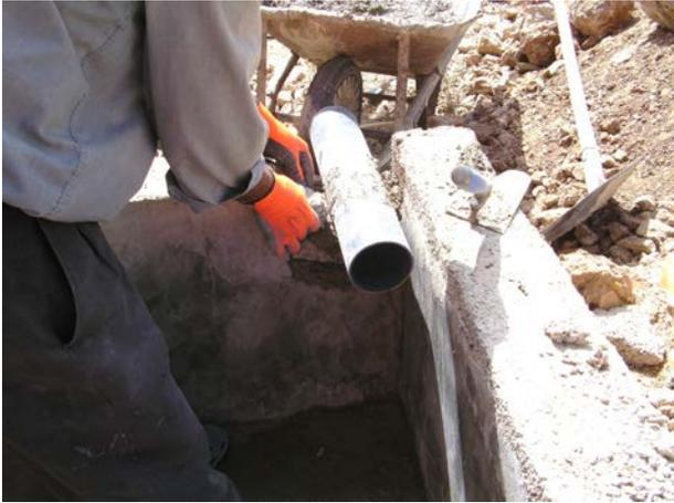
**Image 291** : Mise en place du tuyau de sortie.
