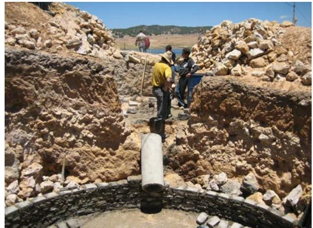
**Image 395** : Vue de la buse du bassin d'expansion. La buse est fixée par un piquet au centre du bassin d'expansion.
