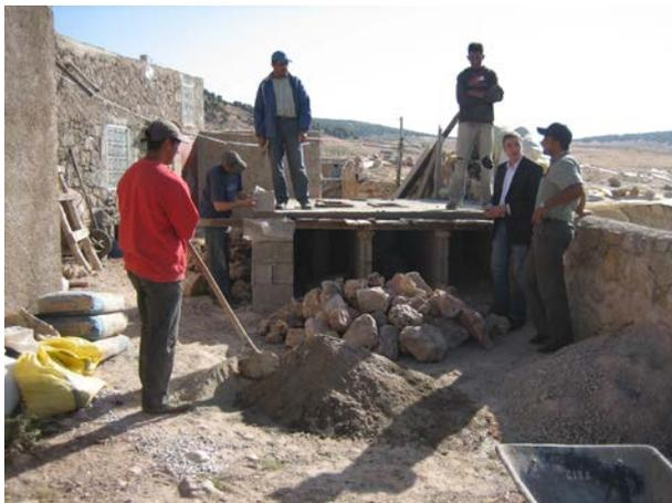
**Image 317** : Le support de la dalle reste lorsqu'on commence avec la maçonnerie de la superstructure.
