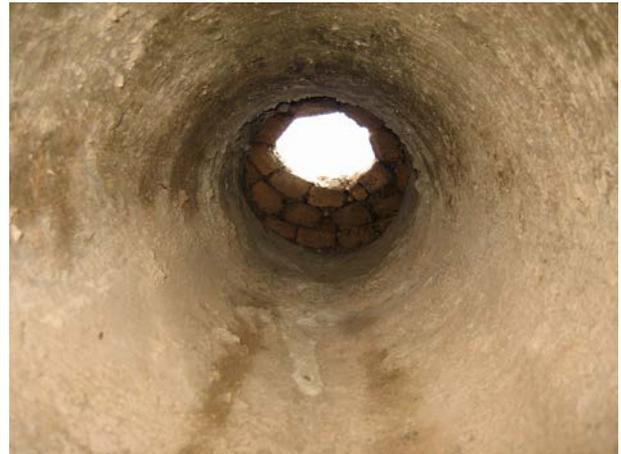
**Image 428** : Buse de sortie vue de l'intérieur du digesteur.
