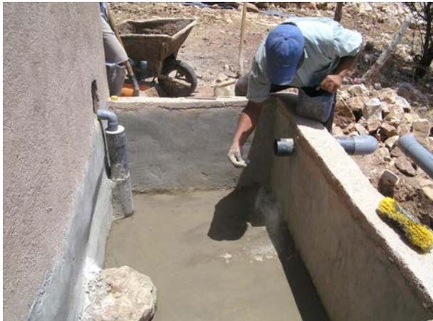
**Image 121 :** Directement après l'application des enduits on peut fermer des fissures avec du ciment pur et un peu d'eau.
