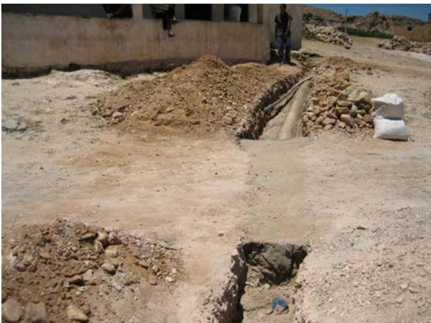
**Image 487** : Le tuyau PVC est enrobé de sable stabilisé au ciment ou au béton armé (sous route).
