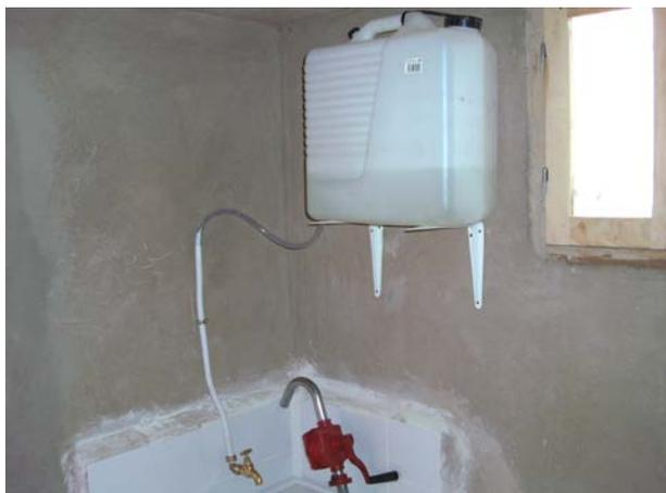
**Image 278 :** Installation du réservoir et des conduites d'eau.
