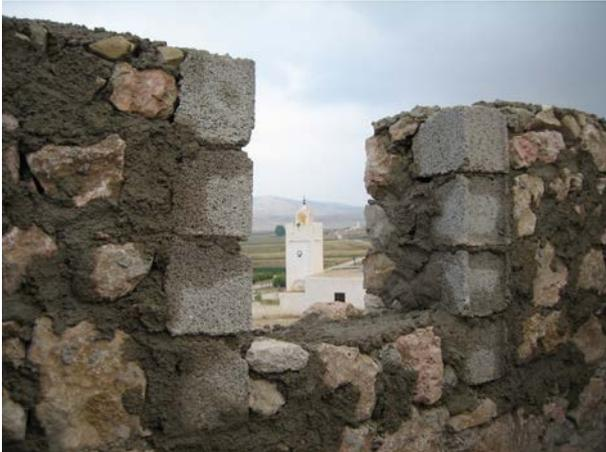
**Image 325** : Des briques sont utilisées à la face interne du mur pour former la niche de la fenêtre.
