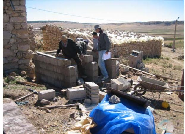
**Image 241** : Une niche est aussi prévue pour le linteau et le tuyau de ventilation.
