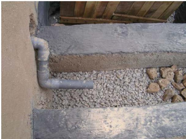
**Image 125** : La conduite des eaux de nettoyage anal est branchée au compartiment d'infiltration. La couche de gravier concassé sera finalement entièrement couverte par des pierres plus grosses.
