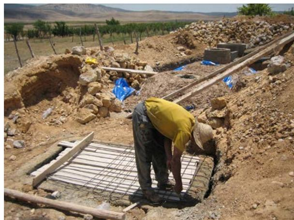
**Image 465** : Préparation du coffrage et ferrailage pour le couvercle de la fosse de stockage.
