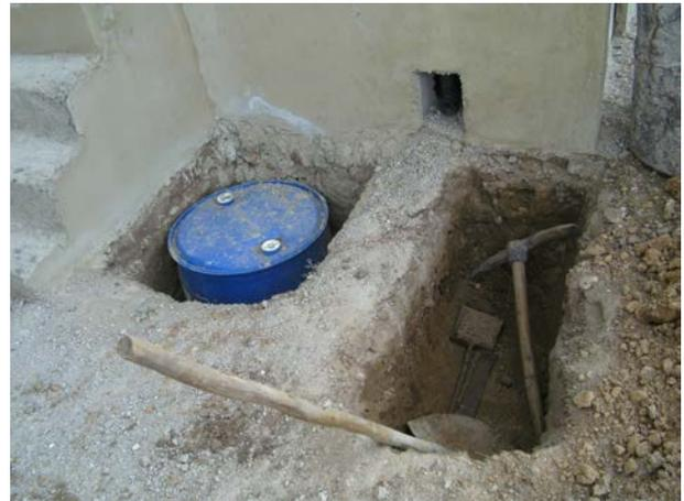
**Image 184** : Le réservoir d'urine est placé et l'excavation de 80 cm est faite pour le filtre pour l'eau de nettoyage anal (puisard).
