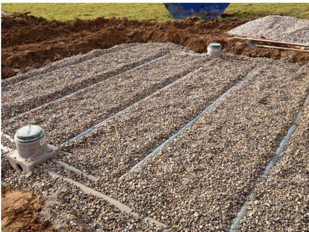
Figure 2: Filtre à graviers en France (source: CHARTEUSE TP).
