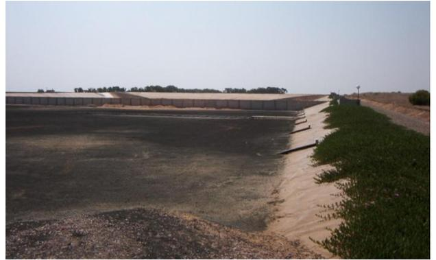
Figure 5: Filtre à sable de la station d'épuration M'Zar près de Agadir, Maroc (source: M. Wauthélet, 2001). Le résidu observé à la surface du filtre est principalement composé d'algues séchées.
