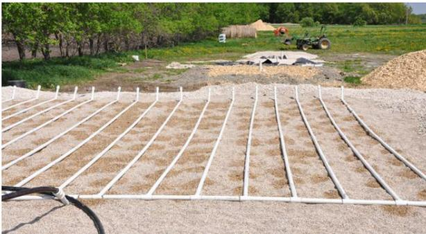
Figure 4: Filtre à sable à Gordon Orchard Farm au Canada (source: Agassiz Enviro-Systems Inc.).
