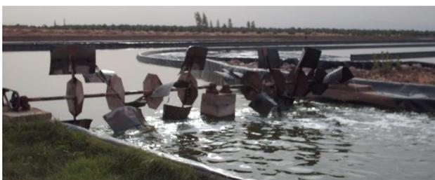
Figure 2: Roue à palettes pour chenal algal. En haut: solution classique avec une roue à huit palettes rigides fabriquées en polyester résistant dans une installation à Casablanca. En bas: station d'El Attaouia roue à palettes multiples en caoutchouc épais souple placées sur différents plans; chenal algal de 6400 m<sup>2</sup> (source: B. El Hamouri, 2006).
