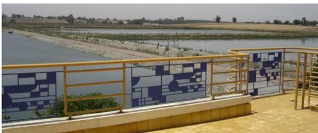
Figure 3: Technologie de « maturation-stockage » appliquée à la STEP de Benslimane. A droite: Bassins de maturation-stockage; à gauche: bassin facultatif (source: B. El Hamouri, 2005).
