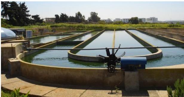
Figure 1: Chenal algal et bassin de maturation de la station prototype de l'IAV à Rabat, Maroc. Chenal algal de 900 m<sup>2</sup> avec roue à palettes. Arrière-plan à gauche: deux bassins de maturation en série (source: B. El Hamouri, 2006).
