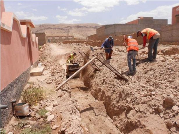
Figure 5: Travaux de pose, de remblayage, et de compactage d'un réseau d'égout conventionnel à la Commune rurale de Douirane, Maroc (source: DRPE - Direction de la Recherche et de la Planification de l'Eau du Ministère de l'Énergie, des Mines, de l'Eau et de l'Environnement du Maroc, 2013).
