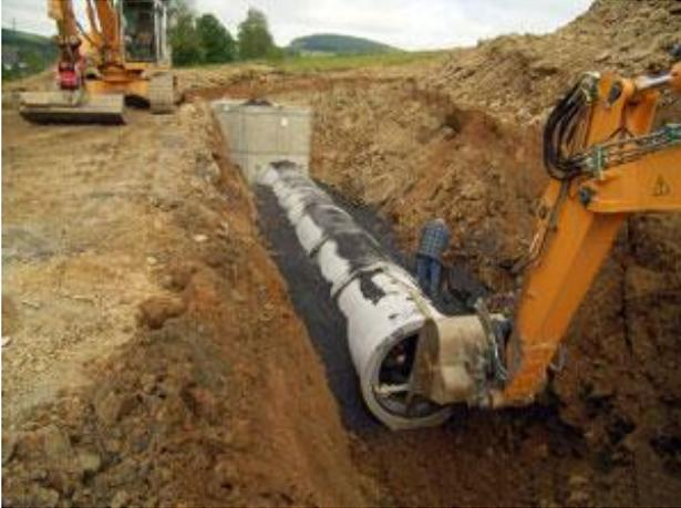
Figure 4: Construction d'un réseau d'égout conventionnel à l'Allegmagne (source: Bauunternehmen Friedrich Müsse GmbH & Co. KG).
