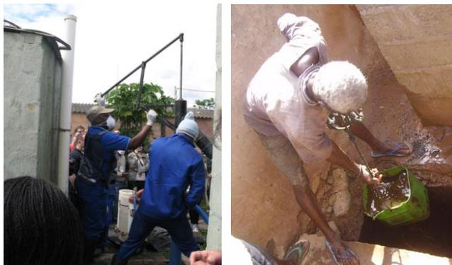
Figure 5: A gauche: Evacuation de boues fécales d'une Ventilated Improved Pit latrine (VIP) à l'aide d'un Gulper à Durban, South Africa; à noter le système à double levier (source: E. von Muench, 2012). A droite: Vidange manuelle d'une fosse simple en utilisant un seau sans vêtements de protection (source: F. Brunner, 2000).
