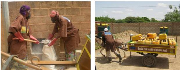
Figure 4: A gauche: Vidange de la chambre de déshydratation d'une TDSU par des agents municipaux à Ouagadougou, Burkina Faso; A droite: Transport par jerrycans de l'urine sur une charrette à traction animale dans la même ville (source: S. Tapsoba, 2009).
