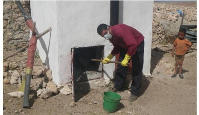
Figure 3: Evacuation manuelle de la chambre de déshydratation d'une TDSU à Dayet Ibrah, Maroc (source: GIZ-AGIRE, 2012).
