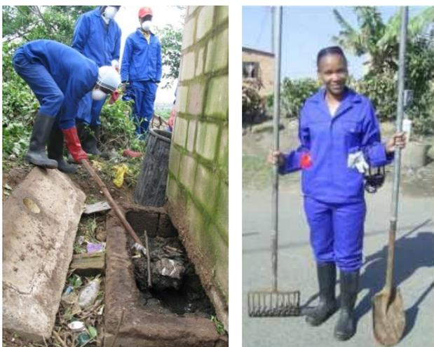
Figure 1: A gauche: Vidange manuelle d'une fosse de latrine traditionnelle à Durban, Afrique du Sud (source: E. von Muench, 2012); A droite: Outils utilisés pour la vidange des fosses de latrines traditionnelles à Durban, Afrique du Sud (source: WRC, 2012).
