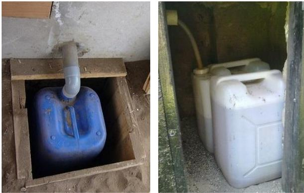
Figure 2: A gauche: Collecte d'urine dans un container en matières plastiques de 20 L (source: H. Hoffmann, 2009). A droite: Container de 20 L placés dans une loge additionnelle en Zambie; à noter que le diamètre du tuyau de collecte est trop faible (source: R. Ingle, 2010).
