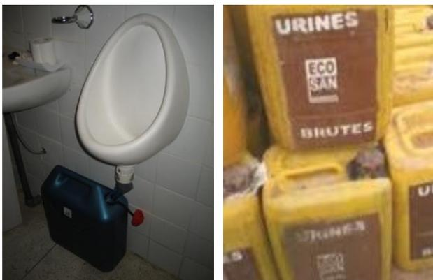
Figure 1: A gauche: stockage d'urine en jerrycan placé sous un urinoir à Dayet Ifrah (source: M. Wauthélet, 2010). A droite: bidons de stockage de l'urine à Ouagadougou, Burkina Faso (source: Tapsoba, 2009).
