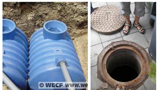
Figure 3: A gauche: réservoir en matières plastiques en Ukraine (source: WECF, 2009). A droite: réservoir de stockage en béton muni d'un trou d'homme (source: E. von Münch, 2007).
