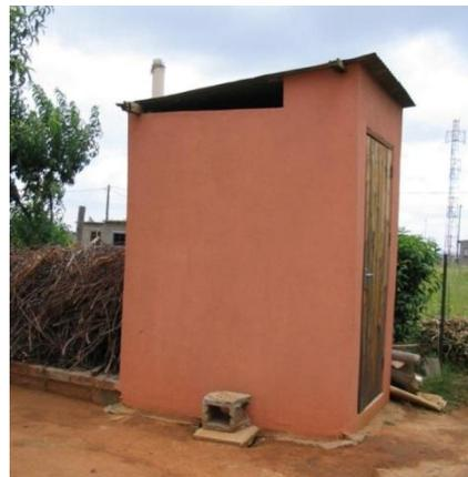
Figure 4: Latrine traditionnelle munie d'un conduit de ventilation à Maseru, Lesotho (source: E. von Muench, 2006).
