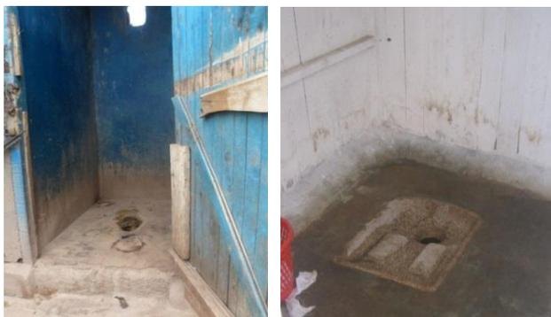
Figure 3: A gauche: Latrine traditionnelle à Nairobi, Kenya (source: D. Mballo, 2012). A droite: Repose-pieds et trou de défécation installés sur une latrine traditionnelle à Lima, Pérou (source: C. Olt, 2009).
