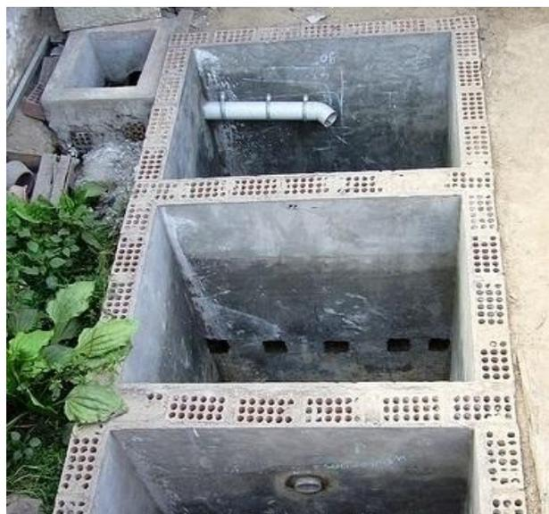
Figure 2: Vue de dessus d'une fosse septique à plusieurs compartiments, avant placement des dalles supérieures (source: Tilley et al., 2008).
