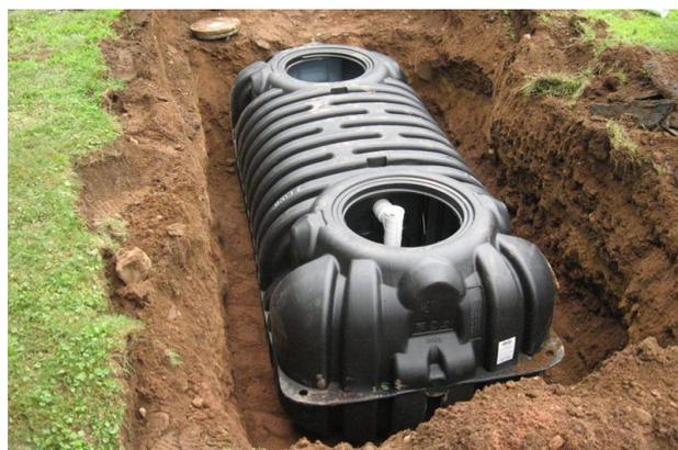
Figure 3: Fosse septique préfabriquée pendant la phase d'implantation, USA (source: Skips Septic Tank Service, Inc., 2013).
