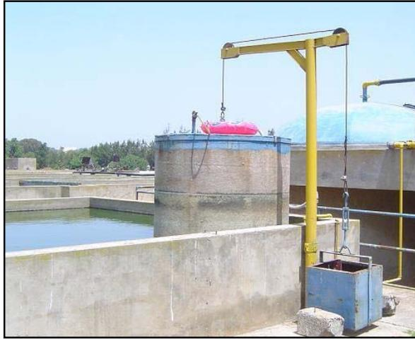
**Figure 41: Gazomètre pour stockage de biogaz**
