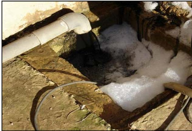
**Figure 43: Evacuation des boues piégées dans le décanteur**
