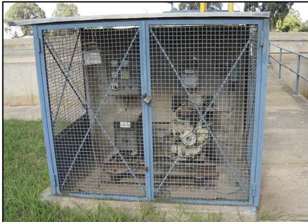
**Figure 42: Groupe électrogène pour la mesure de la quantité de biogaz produite**
