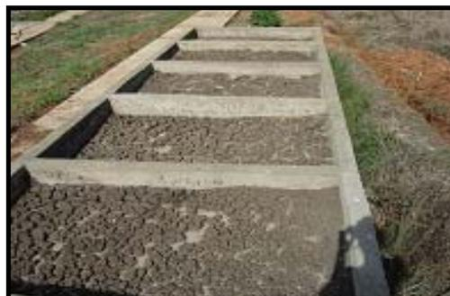
Figure 67: lits de séchage de la boue évacuée
