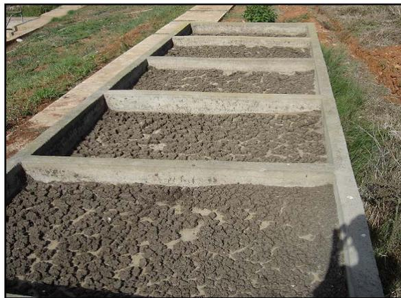
Figure 13: Lits de séchage de la boue évacuée
