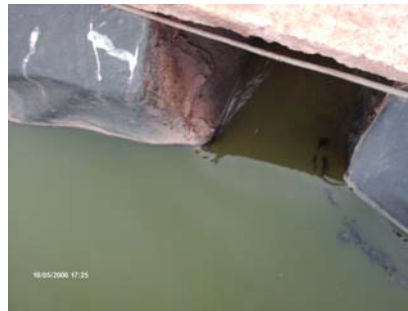
Figure 34 : Déversoir de sortie du CAHR
