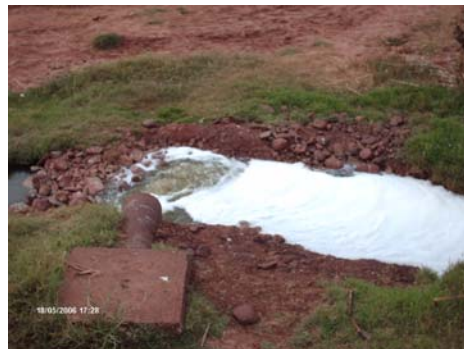
Figure 39: Effluent final de la STEP
