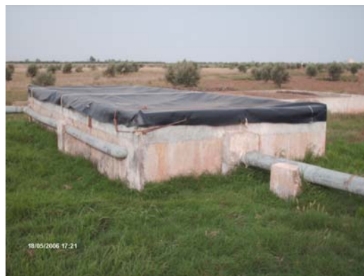
Figure 31: Décanteur
