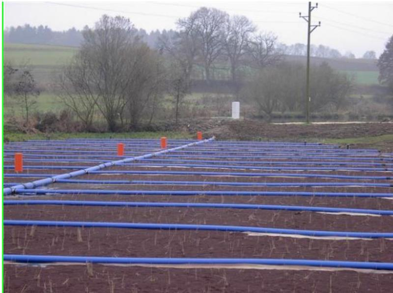
**Figure 69 : Filtre planté en aval de la station de lagunage à Volkertsweiler**
