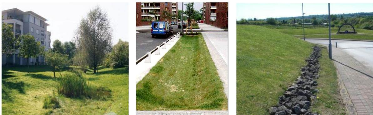
**Figure 76 : Technologies d'infiltration : Bassin d'infiltration, noue végétalisée et tranchée**
