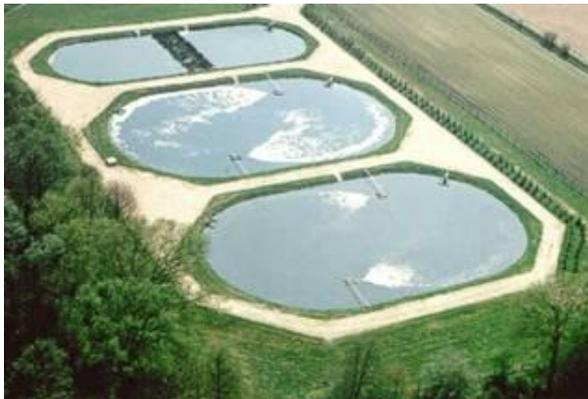
Figure 23 : Lagunage aéré<sup>64</sup>
