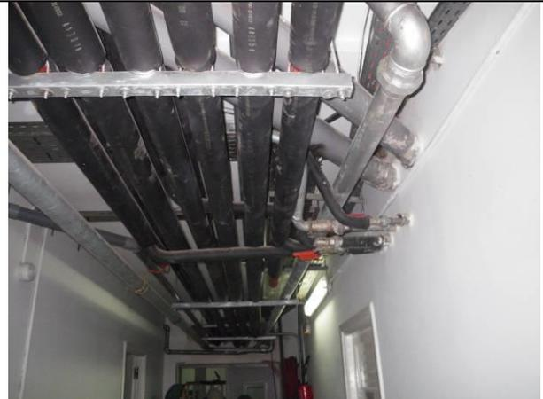
Image 4: Réseau de tuyaux d'évacuation du bâtiment
