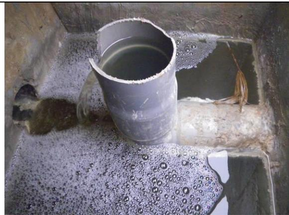
Image 11: Sortie des eaux du Filtre végétalisé
