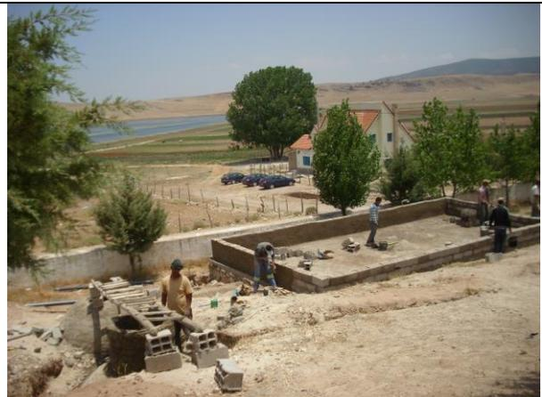
Construction du digesteur 4 m<sup>3</sup> et filtre planté pour l'école et la mosquée (4)
