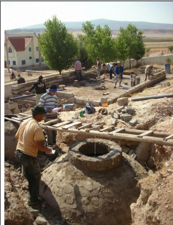
Construction du digesteur 4 m<sup>3</sup> et filtre planté pour l'école et la mosquée (3)
