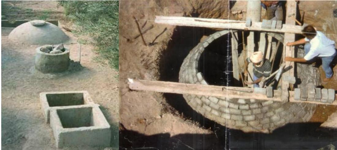
Photo 7 : Digesteurs à dôme hémisphérique (GTZ Maroc/CDER/ORMVA Souss-Massa, 1990)
