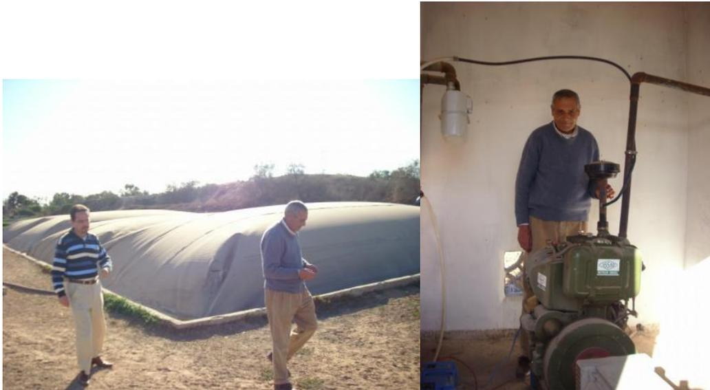
Photo 2 : Station d'épuration de Ben Sergao ; collecte et utilisation du biogaz
