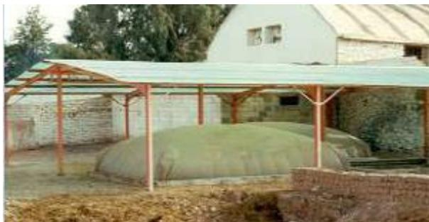
Photo 6 : Digesteurs (discontinus) du CDER à Marrakech (1990) avec gazomètres en bâches souples.
