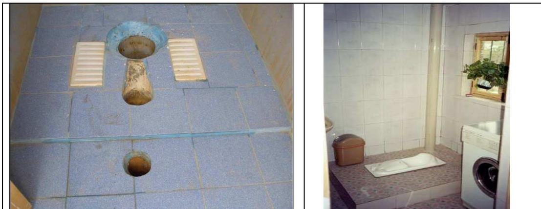
Abb. 9-2 Aufbau einer Trockentoilette mit Urinseparation [GTZ, ecosan (2006)]
