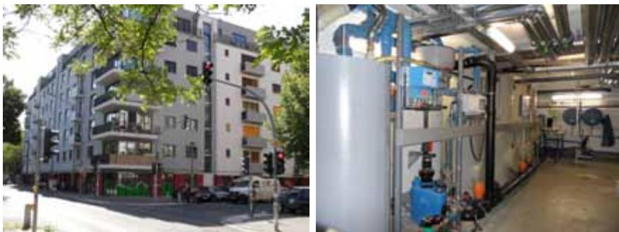
**Foto 1 und 2: Im ersten Berliner Passivhaus für Mieter – mit 41 Wohn- und 4 Gewerbeeinheiten (am Arnimplatz in Berlin-Prenzlauer Berg) – steht im Heizungsraum auf ca. 9 m<sup>2</sup> Stellfläche (ca. 0,1 m<sup>2</sup> pro Bewohner) der Prototyp einer neu entwickelten Grauwasserrecyclinganlage mit vorgeschalteter Wärmerückgewinnung. Er hat eine tägliche Reinigungsleistung von 3 m<sup>3</sup>**
