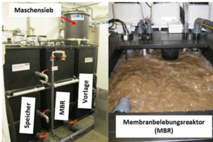
Abbildung 7: Links: Grauwasserbehandlungsanlage der HUBER SE im Haus 1 der GIZ am Standort Eschborn; Rechts: Innenansicht des Membranbelebungsreaktors
