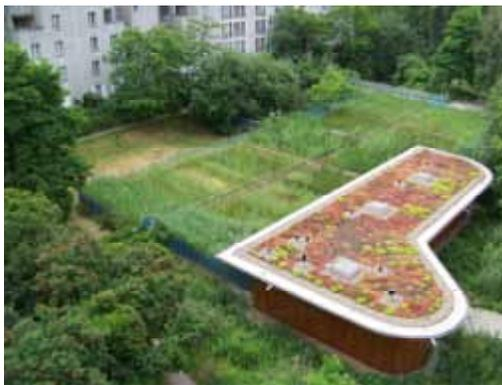
**Foto 3 und 4: Verdunstung von Regenwasser über Schilfpflanzen und Grauwasserrecycling für ca. 200 Mieter in der Berliner Innenstadt (Block 6 in Kreuzberg)**
