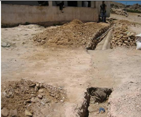
Tuyau PVC 110 mm enrobé de sable stabilisé au ciment ou au béton armé (sous route)
