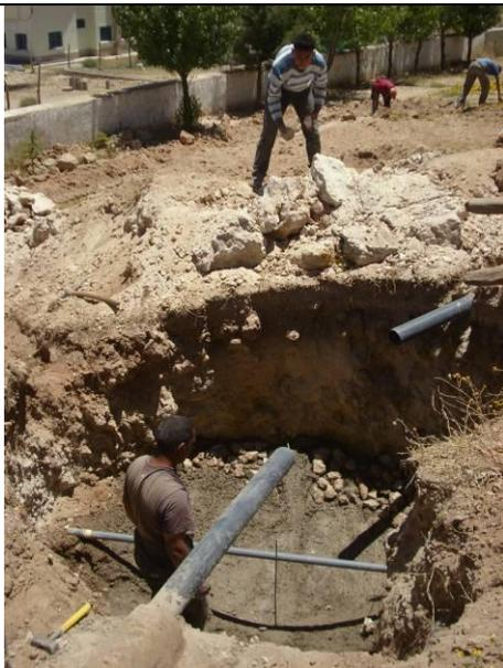
Arrivée des tuyaux d'eaux usées de l'école et de la mosquée et terrassement pour le digesteur (pré-traitement)
