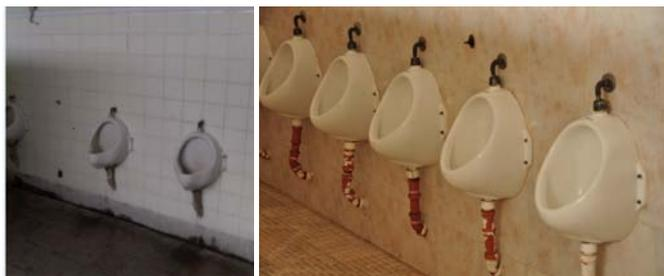
**Fig. 5:** Sanitarios de varones antes (a la izquierda) y después de la ejecución de la separación de efluentes (a la derecha). Previo a la ejecución de proyecto, la orina caía sobre una canaleta abierta, generando problemas de olores y sanitarios (origen: L. Bertaina/ D. Hock, 2009/ 2011).
