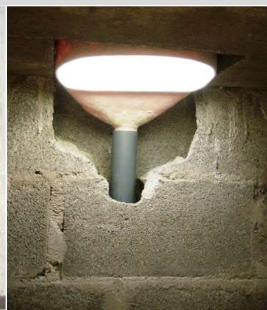
FOTO N° 8: Vista interior con taza
