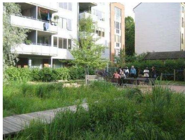
Figura 2. Tratamiento descentralizado de aguas grises urbanas en un humedal artificial de flujo subsuperficial Klosterenga en Oslo, Noruega (foto L. Ulrich, 2008).
