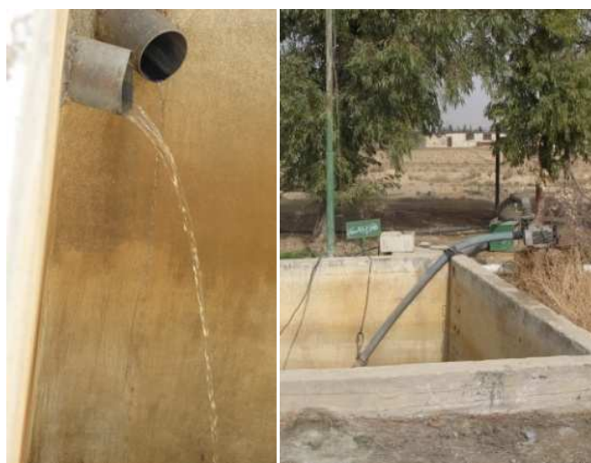
Figura 3. Izquierda: Efluente tratado en humedales artificiales de flujo vertical, Haran Al-Awamied-Siria. Derecha: Estanque antes de su reutilización para el riego agrícola (fotos E. von Muench, 2009, proyecto apoyado por GIZ).
