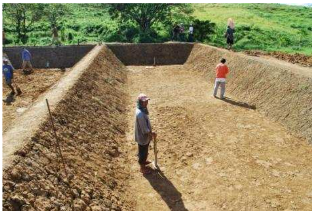
Figura 7. HFV en Bayawan City, Philippines para tratar lixiviados de un vertedero durante su construcción; (foto J. Boorsma, 2009; proyecto apoyado por GIZ).
