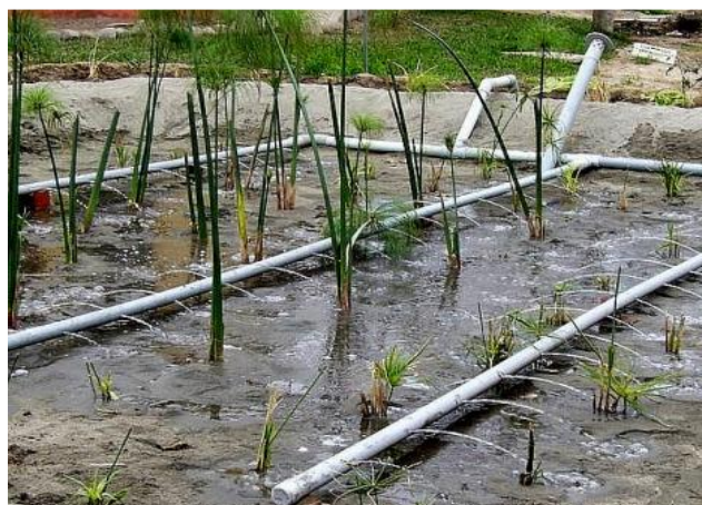
Figura 6. Humedal de flujo vertical (HFV) en Lima, Perú durante la prueba de bombeo para comprobarla distribución. El agua gris pretratada sale por pequeños orificios de los tubos de distribución. Los tubos fueron posteriormente cubiertos con grava. En el flujo vertical se utiliza toda la superficie como área de entrada. (foto H. Hoffmann, 2008).
