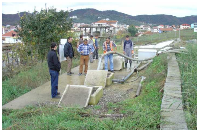
Figure 13. Procesos para sacar el lodo sedimentado del pretratamiento de un HA en Tirana, Albania. El lodo se transporta con camión cisterna para su posterior tratamiento en una planta de tratamiento de aguas residuales (proyecto apoyado por GIZ, foto J. Nowak, 2010)
