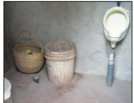
Abb.38: Urinal mit Eimer für Trockenmaterial und Korb für gebrauchtes Toilettenpapier (eigene Aufnahme)
