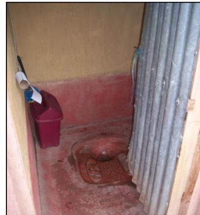
Abb.54: Installiertes LCAH im Distrikt San Salvador (eigene Aufnahme)
