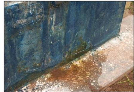
Abb.44: Austretende Feuchtigkeit aus den, bei Regen überschwemmten, Kammern (eigene Aufnahme)
