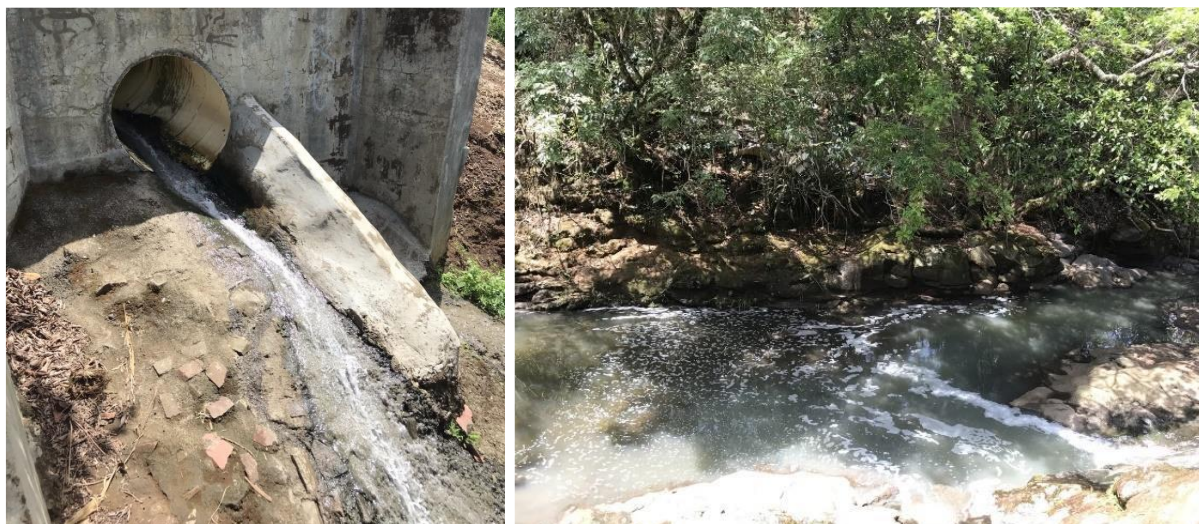
Figura 9: Vertidos de aguas residuales por conexiones ilegales al alcantarillado pluvial, sobre el río Bermúdez. Fuente: Zuñiga y Quesada (2020).
