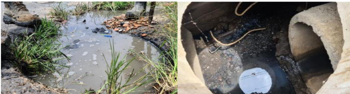
Figura 4: Conexiones clandestinas al alcantarillado pluvial. Fuente: Zuñiga y Quesada (2020). Saneamiento in-situ
