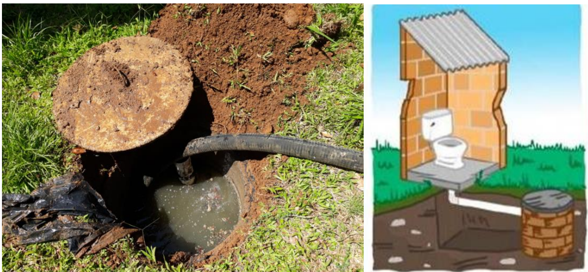
Figura 5: Tanque séptico rudimentario y esquema ilustrativo (utilizado en la encuesta georreferenciada).
