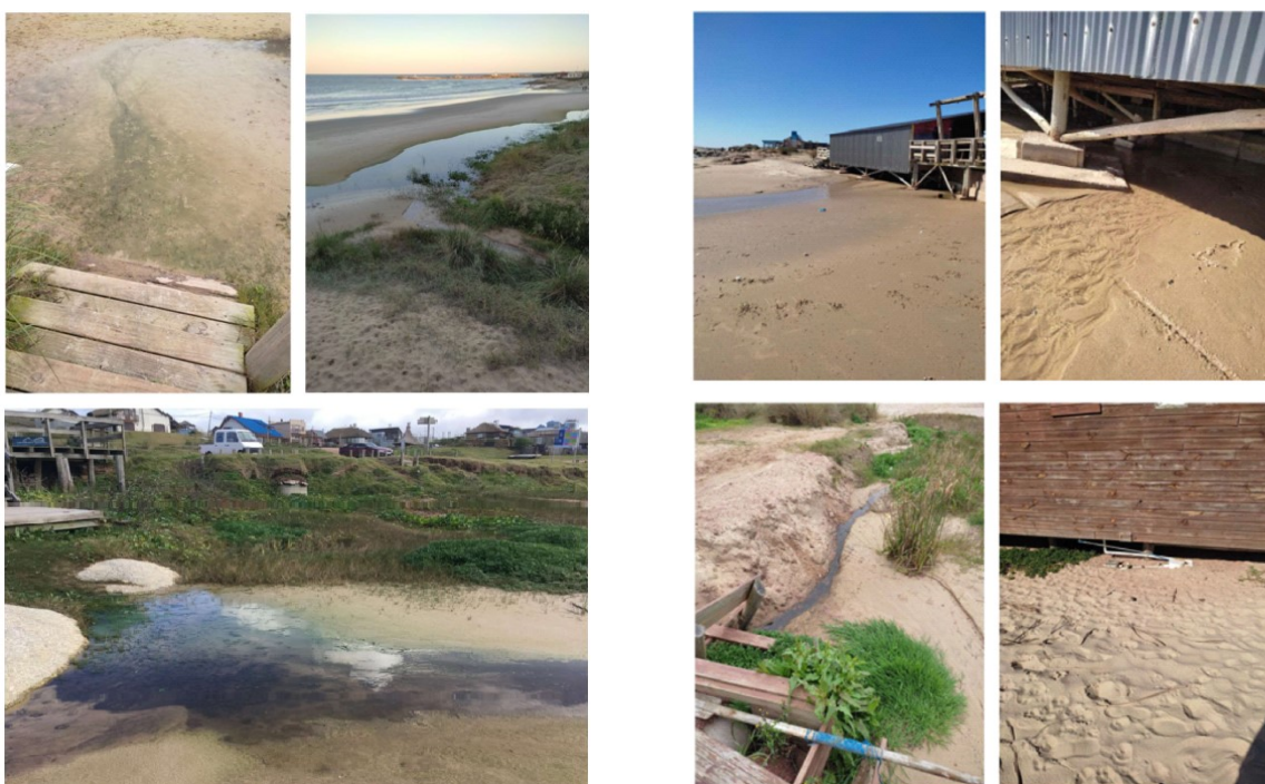
Figura 6: (Izda) Problemas identificados en Playa del Rivero; (Dcha) Problemas identificados en Playa de los Pescadores. Fuente: (D&A y EP, 2021).
