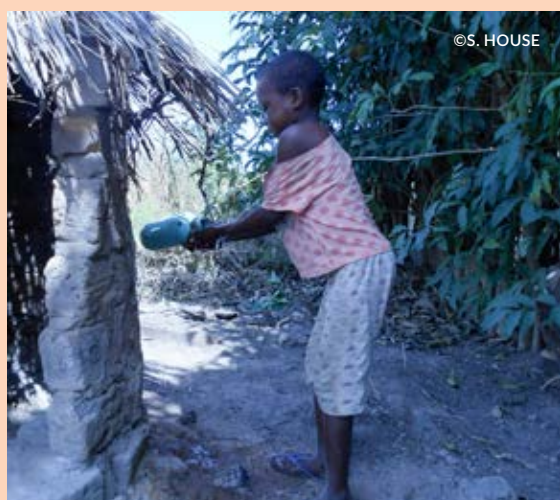
Deux mini-latrines pour enfants au Nigéria . Celles du haut, qui sont légèrement surélevées par rapport au sol, ont été construites par Margaret, un membre du comité WASH.
