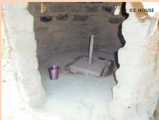
Une dame très âgée et aveugle parvient à s'accroupir, mais a beaucoup de difficultés à utiliser correctement un orifice de taille standard. L'orifice a par conséquent été élargi par son fils, qui a construit les latrines pour elle. (Nigéria)
