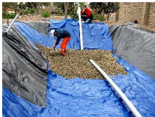
Fig. 3: Tubo de drenagem no fundo do "wetland" (várzea artificial cultivada) para tratamento de águas negras, durante sua cobertura com cascalho. Para evitar perfurações pelo cascalho, o revestimento de PVC de 5 mm (preto) precisava de proteção especial, tendo sido um segundo revestimento (azul) então implantado.<sup>1</sup>
