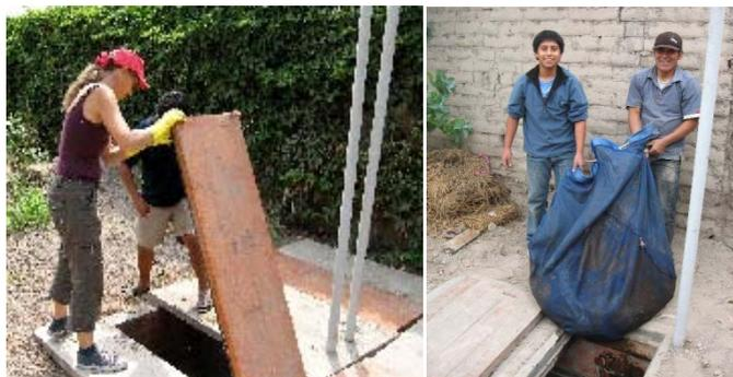
**Fig. 6:** Galeria bicompartimentada com filtro ("Rottebehälter") para pré-tratamento de águas negras (esquerda) e remoção de um saco-filtro (direita).
