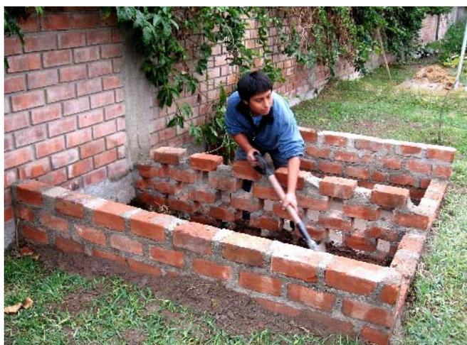
**Fig. 7:** Espalhamento dos sólidos retidos pelo saco-filtro, após 6 meses (ver Fig. 6) no leito de vermicompostagem sobre piso cimentado.
