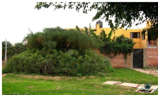
**Fig. 19:** *Wetland* para tratamento de águas cinzas, vegetado com duas espécies de papiros, após 1 ano em operação.
