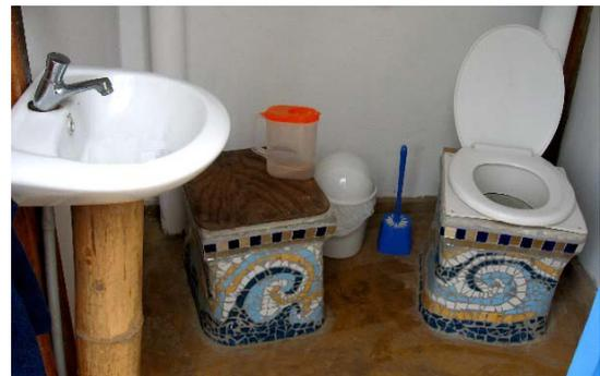
Fig. 10: Banheiro seco, dentro de um dos recintos (2 latrinas coloridas, com separador de urina; só uma está em uso, por até cerca de um ano).
