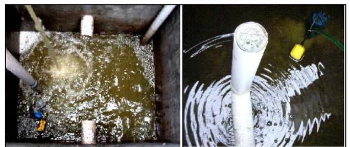
**Fig. 4:** Vertedouro do filtro orgânico para o pré-tratamento de águas negras (esquerda), e efluente do *wetland* vegetado com papiros para tratamento final de águas negras (direita).
