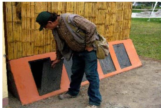
Fig. 11: Duas galerias bicompartimentadas para a coleta de fezes, nos fundos dos banheiros (4 câmaras ao todo).
