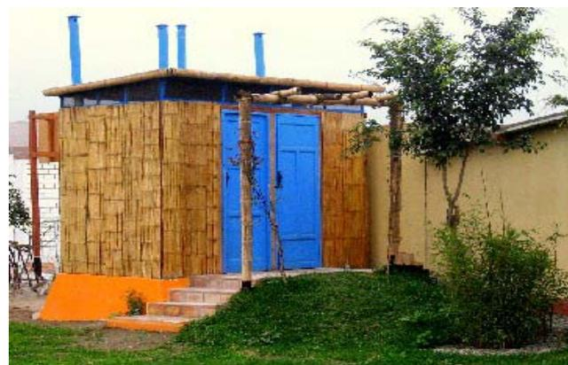
**Fig. 9:** Banheiros para separação de urina e desidratação de fezes, na área externa, com o leito de filtragem por cascalho para águas cinzas (no canto, à direita).
