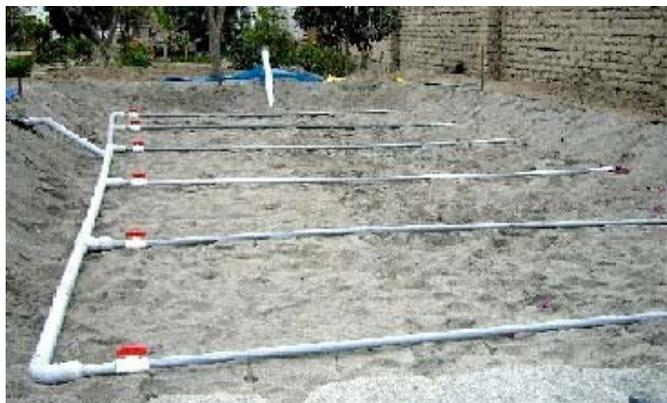
**Fig. 18:** Sistema de distribuição do segundo *wetland* (para tratamento de águas negras) antes do plantio, mostrando válvulas à esquerda, em vermelho, para evitar entupimento (carga intermitente).
