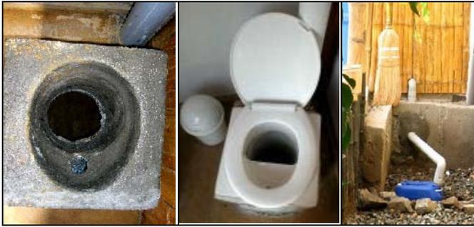
**Fig. 12:** Latrinas com (à esquerda) e sem (ao centro) a peça plástica acoplada para o desvio de urina. Cano proveniente da peça separadora, desaguando em bujão de 25 litros (à direita).
