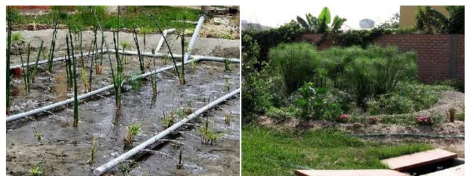
**Fig. 5:** *Wetland* de fluxo vertical para tratamento de águas cinzas, durante bombeamento (um dia após o plantio e antes da proteção dos canos distribuidores com uma camada de 10 cm de cascalho), à esquerda, e depois de dois meses, com tanque de armazenagem de águas cinzas para irrigação, à direita.
