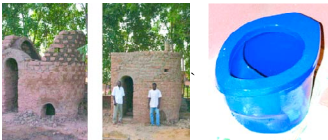
Figure 7. Construction d'une latrine double fosse en banco sans bois.
