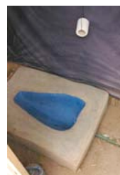
Burkina Faso - urinoir femme en fibre de verre et ferrociment
