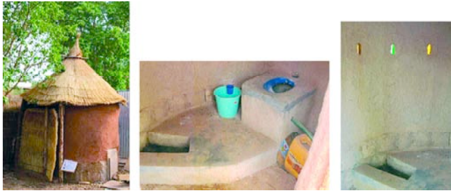
Figure 6. La superstructure de la latrine en matériaux locaux. Siège de type « box ». L'urine est récupérée dans le bidon et la matière fécale dans un seau dans le « box » en ferrociment. Le lavage anal se fait sur l'espace désigné en face du box. Des bouillottes sont incorporées dans le mur pour donner de la luminosité.
