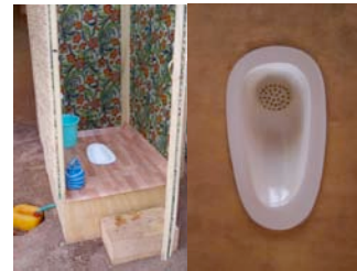
Burkina Faso - urinoir femme en fibre de verre et ferrociment
